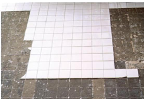
Figura 4: descolamento de placas cerâmicas (CICHINELLI, 2006)
