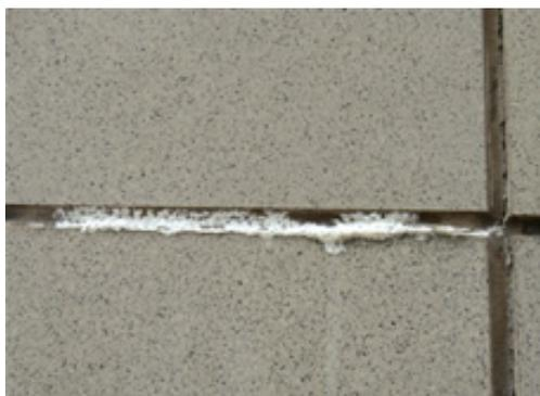
Figura 5: eflorescências em revestimento cerâmico (CICHINELLI, 2006)
