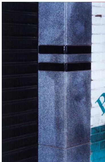
Figura 7: manchas em granito proveniente de água das chuvas (IAMAGUTI, 2001)
