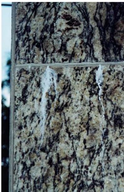
Figura 8: pontos de eflorescências a partir da junta horizontal (IAMAGUTI, 2001)
