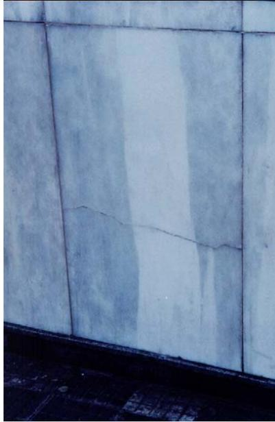
Figura 9: trincas causadas pela junta de dilatação insuficiente (IAMAGUTI, 2001)
