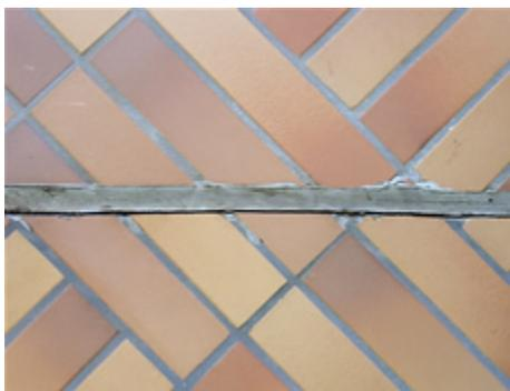
Figura 6: falha da junta de movimentação, facilidade para entrada de água (CICHINELLI, 2006)
