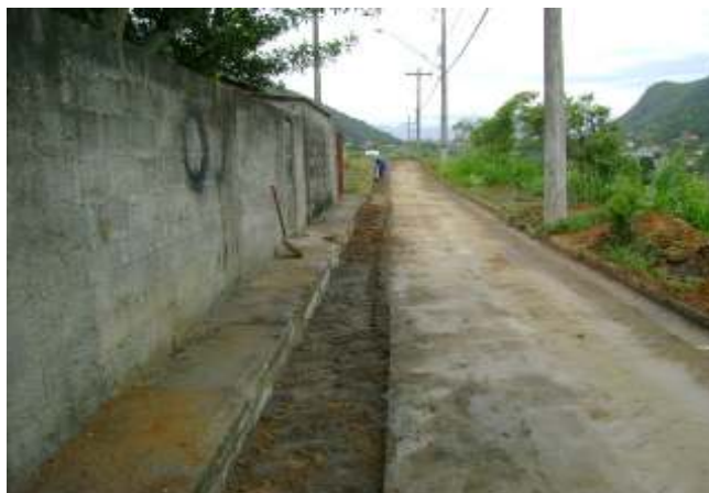
Figura 12: compactação da vala (trabalho não publicado) 16
