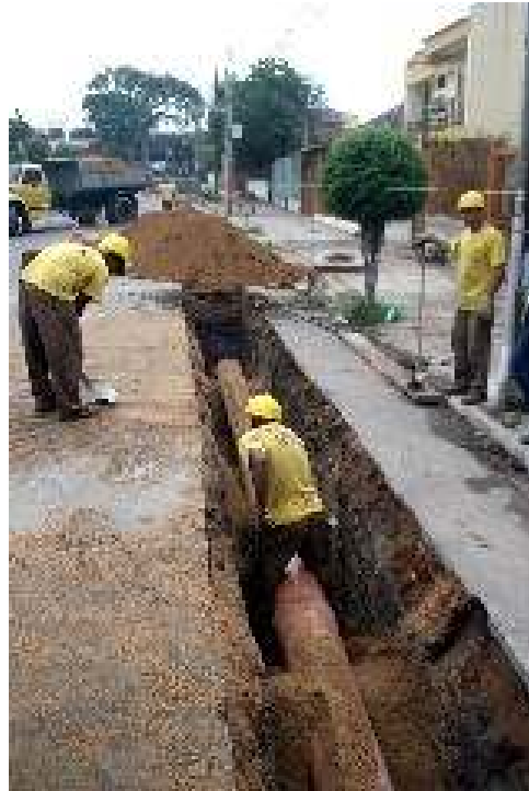
Figura 9: assentamento da tubulação (trabalho não publicado) 14
