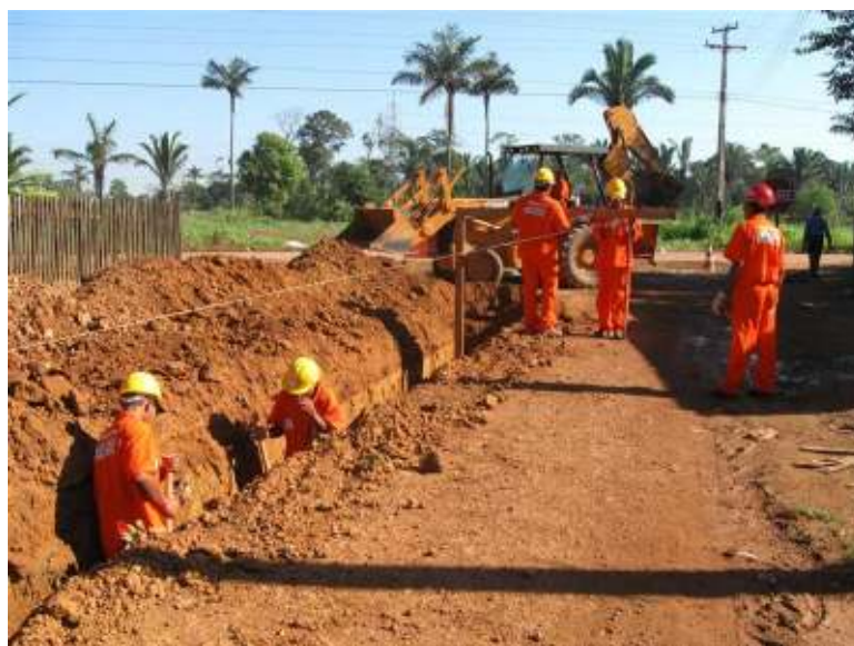
Figura 11: reaterro da vala (trabalho não publicado) 15
