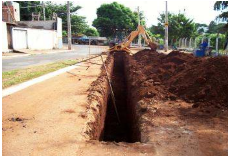
Figura 7: escavação mecânica (trabalho não publicado) 8
