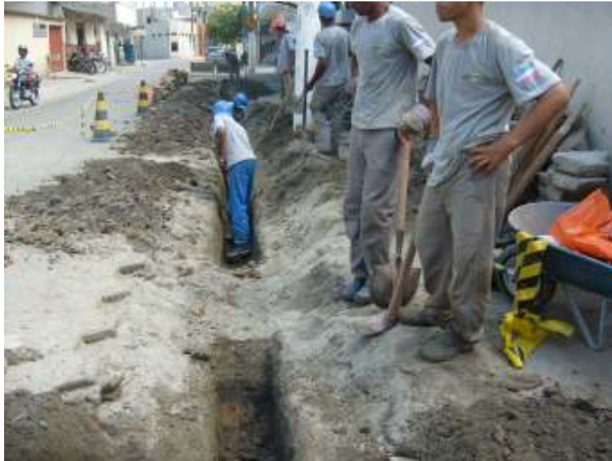
Figura 6: escavação manual (trabalho não publicado) 7
