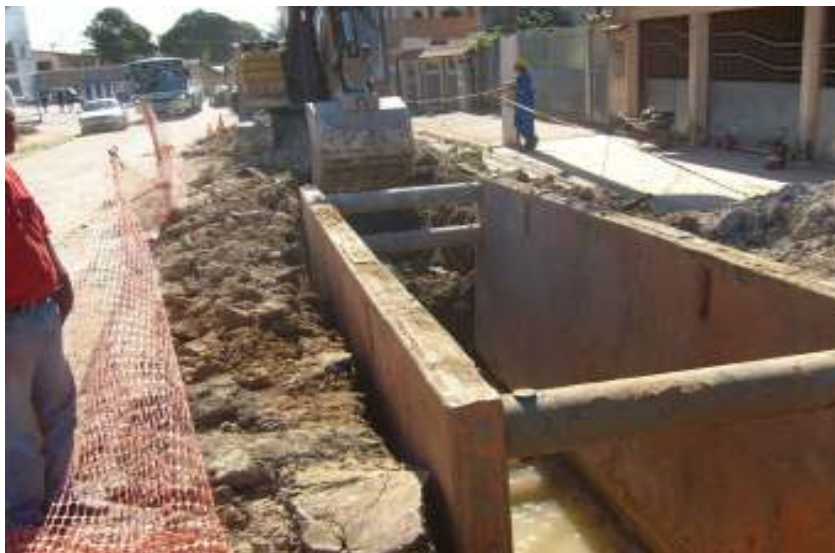
Figura 8: escoramento metálico em obra de esgoto sanitário (trabalho não publicado) 10
