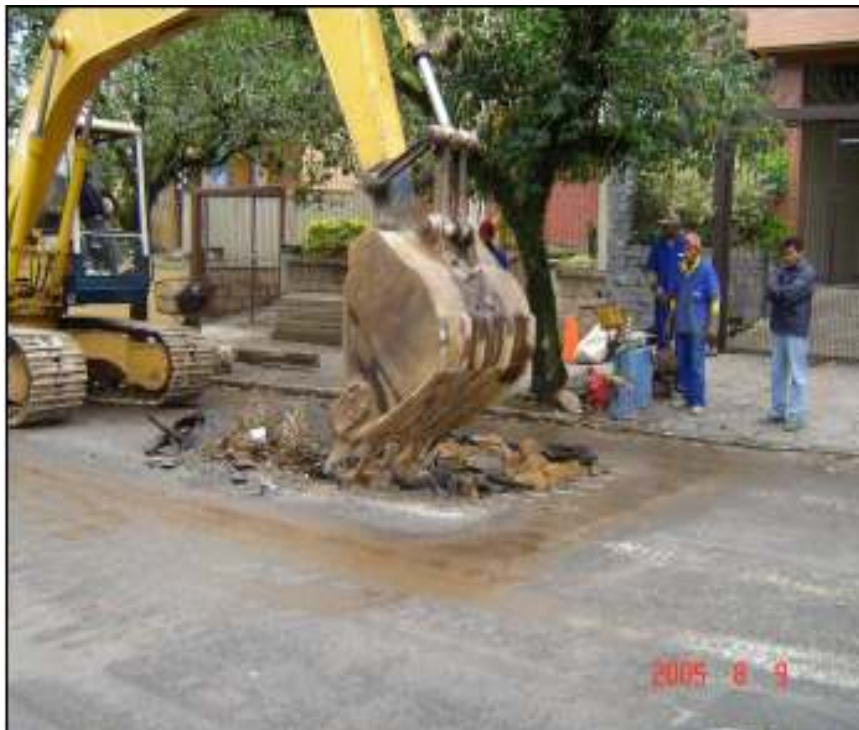
Figura 5: remoção do pavimento com máquina escavadeira (trabalho não publicado) 5
