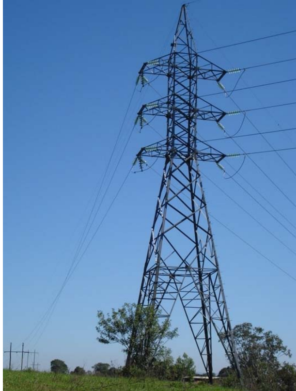
Figura 2: torre metálica autoportante
