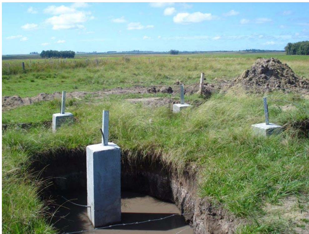
Figura 4: sapatas para torre autoportante
