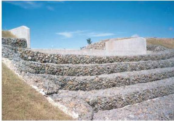
Figura 5: vertedouro de gabião (GONZALEZ et al., 2005, p. 4)
