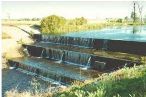
Figura 6: vertedouro com patamares em bacia (CHANSON, 1998, p. 16)
