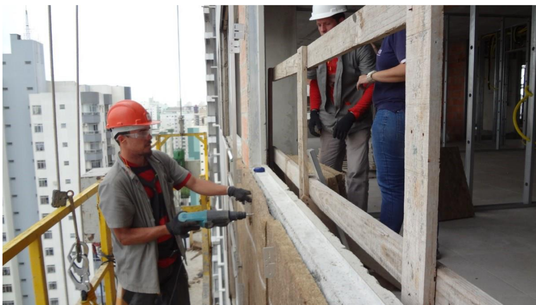
Figura 19 – Instalação do isolamento térmico utilizando balancim elétrico
