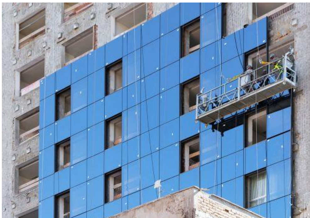
Figura 02 – Fachada ventilada revestida em vidro
