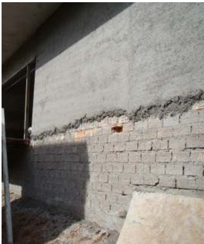
Figura 4: revestimento em argamassa
