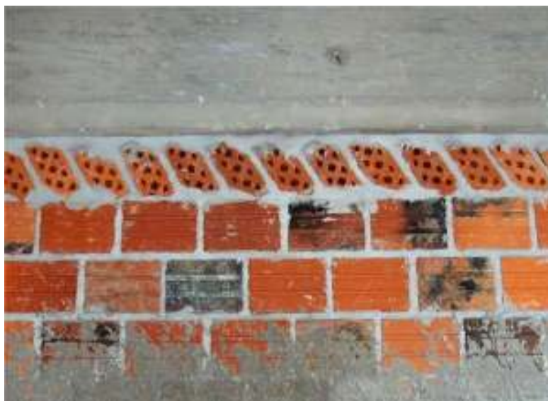
Figura 5: encunhamento rígido com blocos cerâmicos inclinados a 45°
