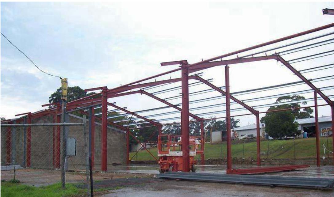
Figura 2: edifício industrial formado com pórticos em perfis de alma cheia
