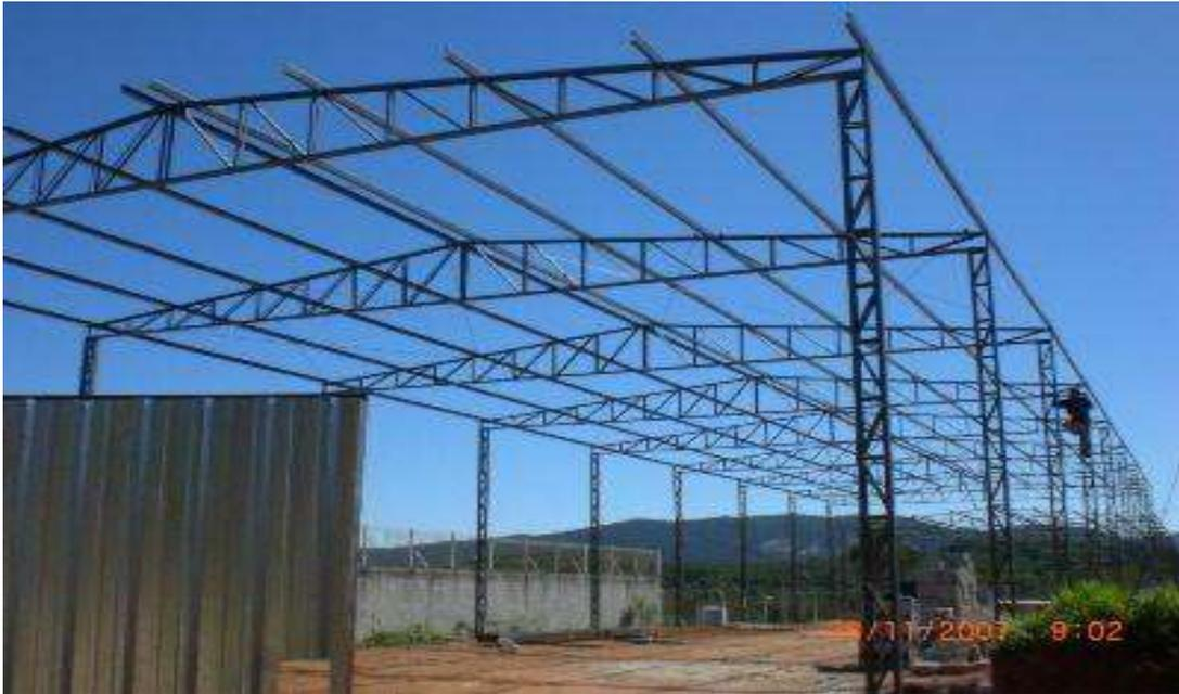
Figura 3: edifício industrial formado com pórticos treliçados
