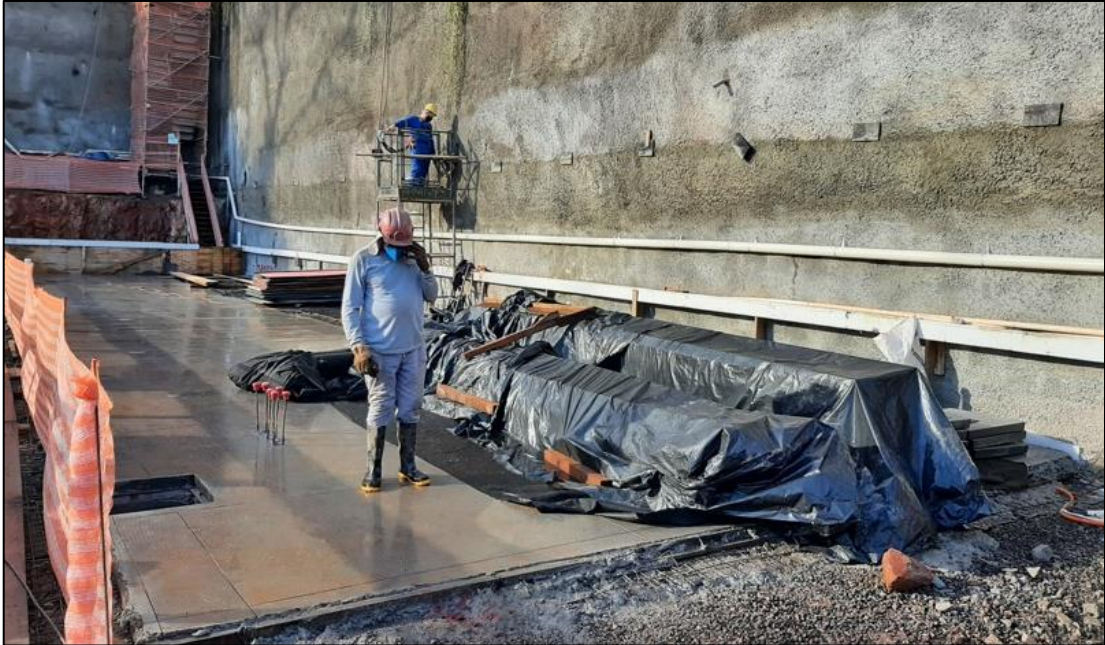
Figura 10 – Piso polido concretado utilizado como armazenamento de materiais
