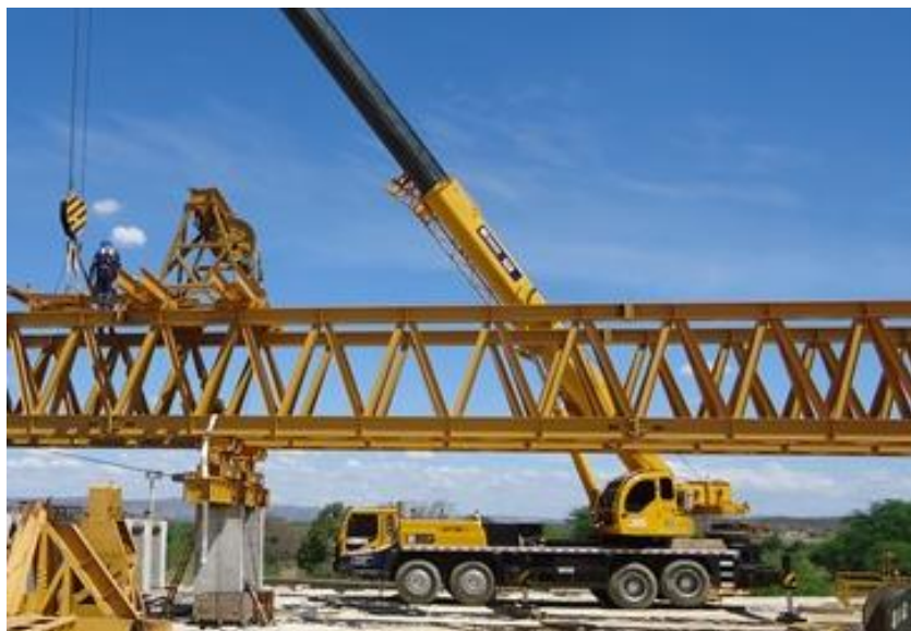
Figura 16 – Montagem de grua estacionária de torre fixa com auxílio de guindaste móvel
