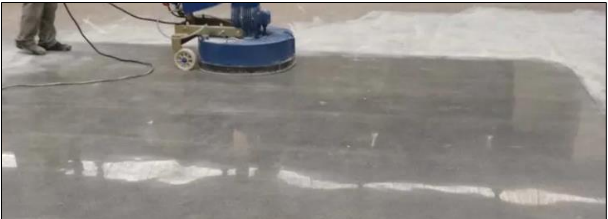
Figura 11 – Processo de lapidação de concreto polido
