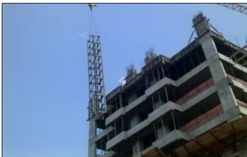
Figura 28 – Processo de montagem de elevador cremalheira
