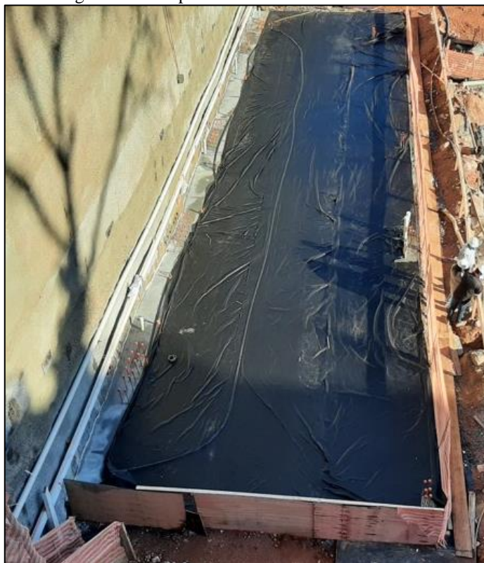
Figura 9 – Piso polido concretado em fase de cura
