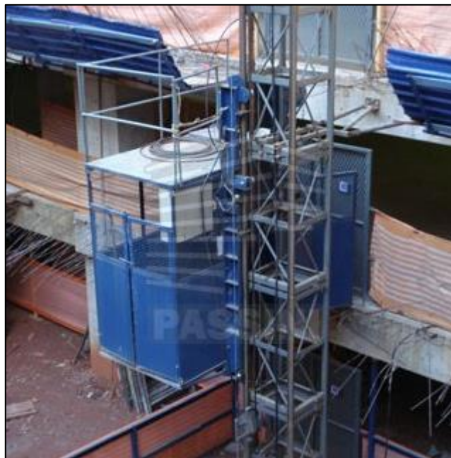
Figura 27 – Elevador cremalheira instalado em canteiro de obras
