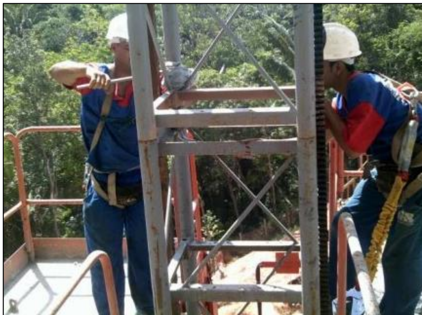
Figura 29 - Montagem manual de elemento do elevador cremalheira
