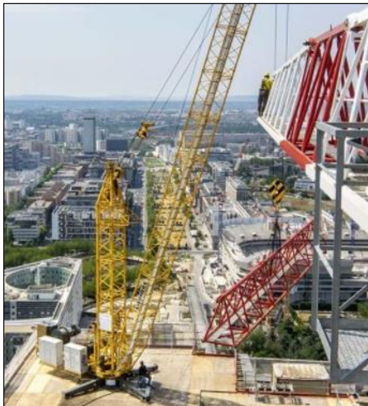
Figura 24 – Guindaste do tipo derrick desmontando uma grua ascensional
