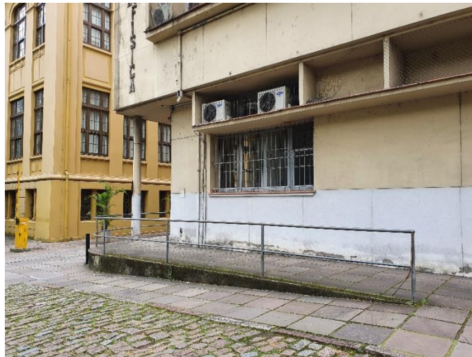
Figura 111 – Rampa da rota 4
