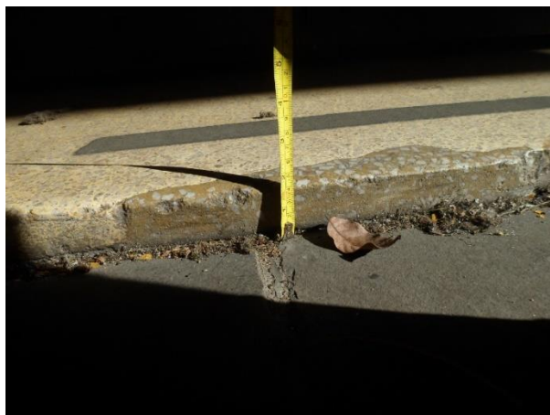
Figura 95 – Degrau em frente à entrada do Anexo I da Reitoria
