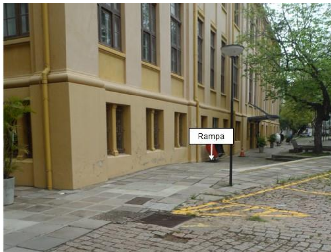
Figura 113 – Rampa da rota 5
