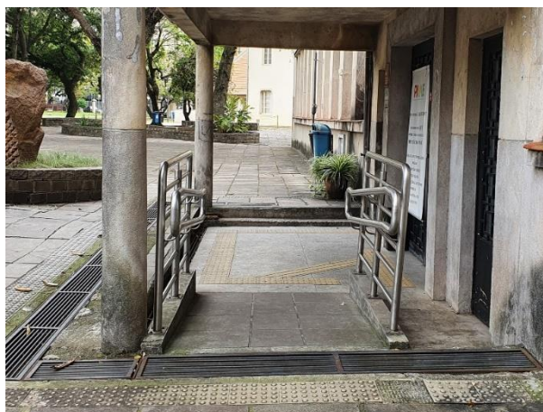
Figura 121 – Degrau isolado com dois degraus na rota 1
