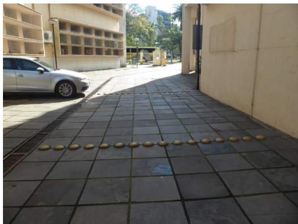
Figura 93 – Estacionamento e calotas de sinalização de trânsito
