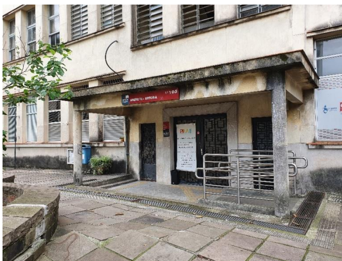
Figura 109 – Lateral da rampa de acesso da PRAE
