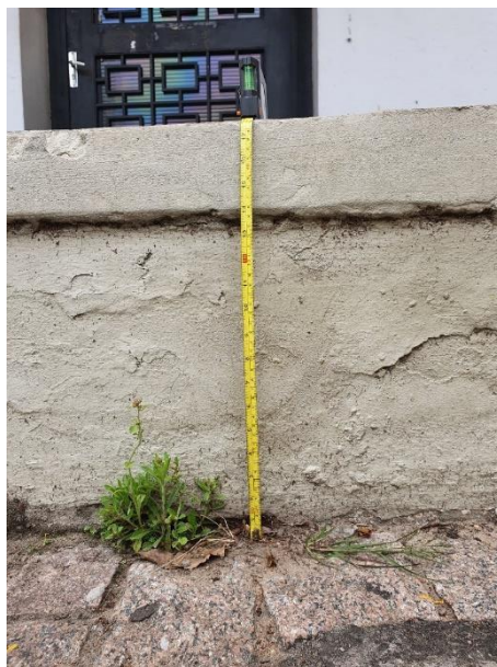
Figura 76 – Desnível do corredor da rota 4
