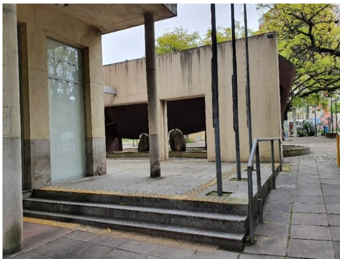
Figura 123 – Escada fixa e degrau isolado da rota 2
