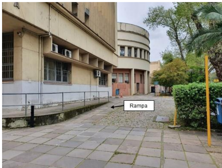
Figura 82 – Rampa da rota 4
