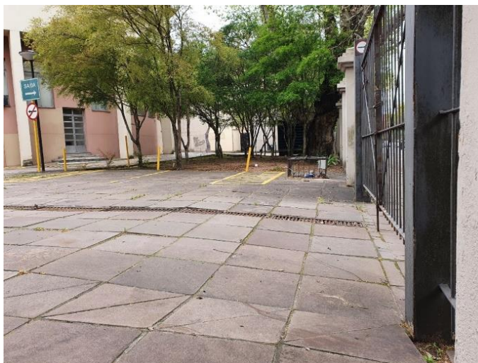
Figura 115 – Rebaixamento de calçada da rota 6
