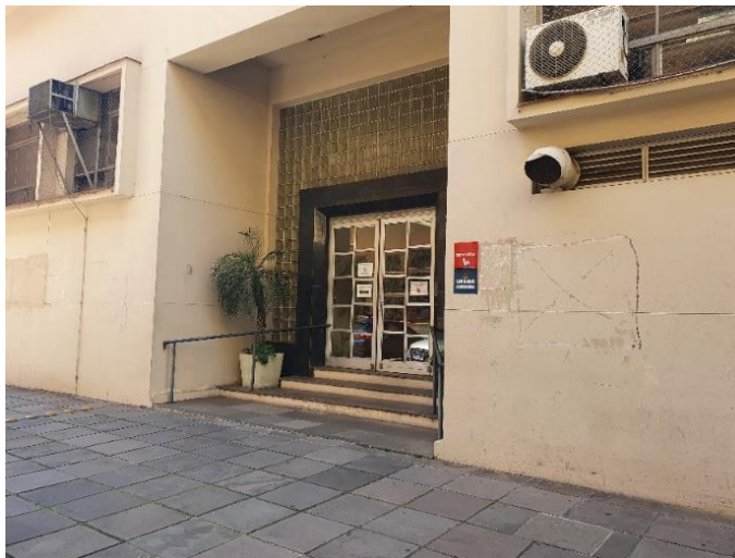
Figura 129 – Escada de acesso ao prédio da Reitoria na rota 6
