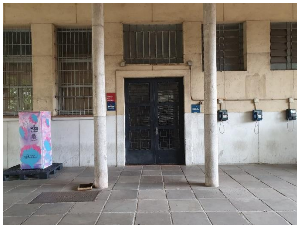
Figura 66 – Acesso da Central de Identificação
