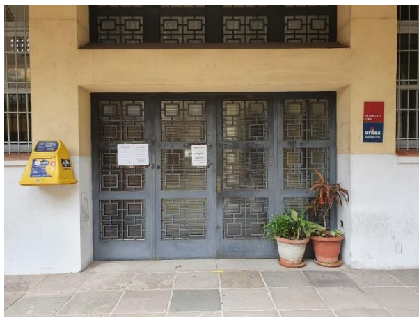
Figura 70 – Acesso do Protocolo Geral
