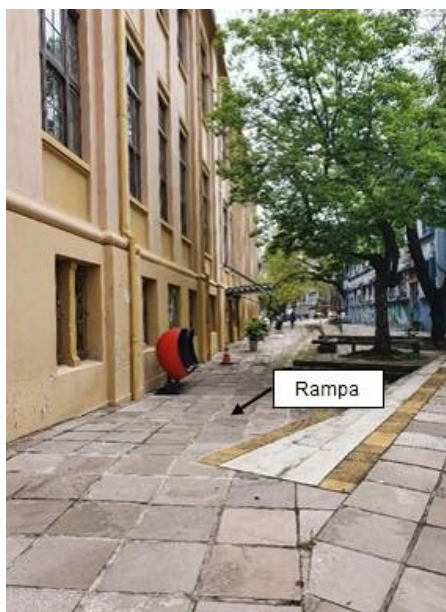
Figura 85 – Rampa da rota 5
