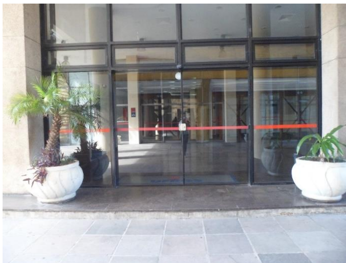
Figura 133 – Degrau isolado com um degrau da rota 7
