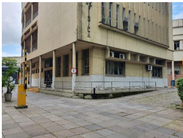
Figura 80 – Guarda corpo na rota 4
