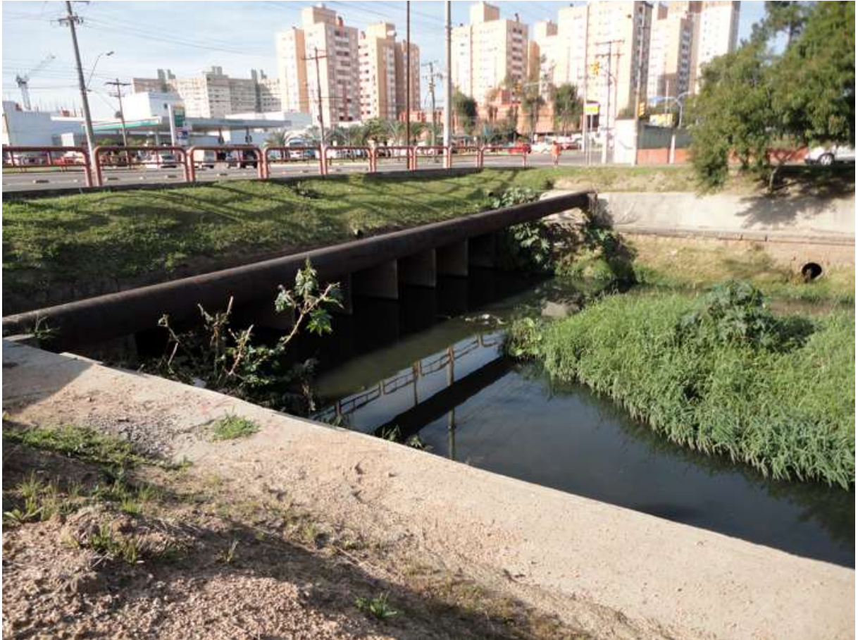
Figura 5 - Seção D6a à jusante da rua Cristiano Fischer
