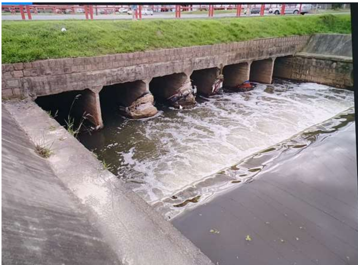
Figura 17 - Degrau à montante da ponte da rua Cristiano Fischer
