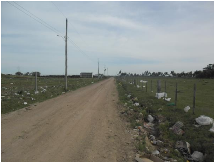
Figura 8. Acessos externos em boas condições, porém com resíduos dispersos na área do entorno
