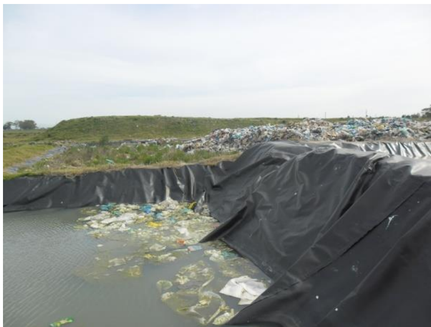
Figura 13. Lagoas de lixiviado em estado precário de conservação
