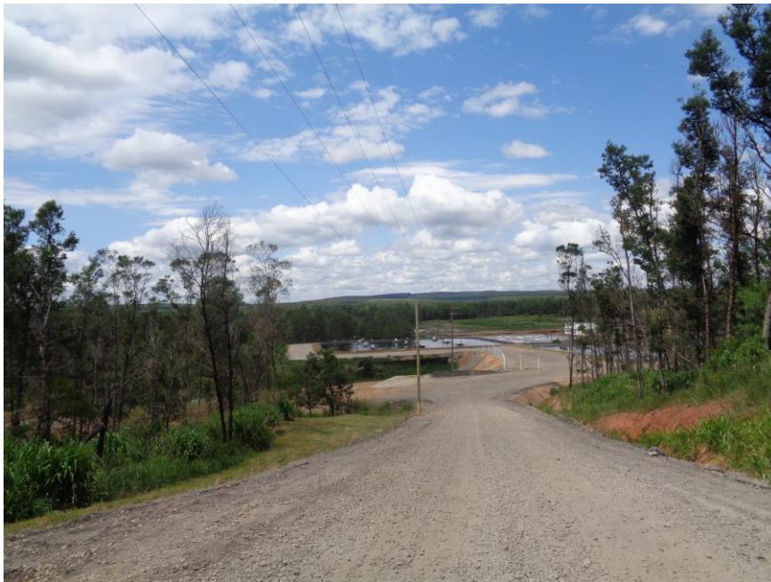
Figura 16. Acessos internos em boas condições
