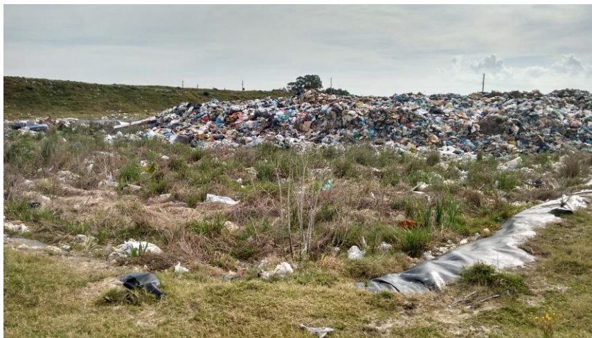
Figura 12. Frente de trabalho sem equipamento de compactação
