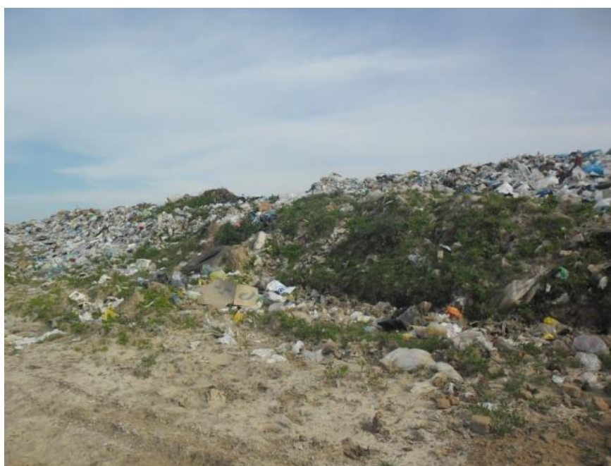
Figura 14. Célula de disposição sem cobertura e sem drenagens de pluvial e de gases
