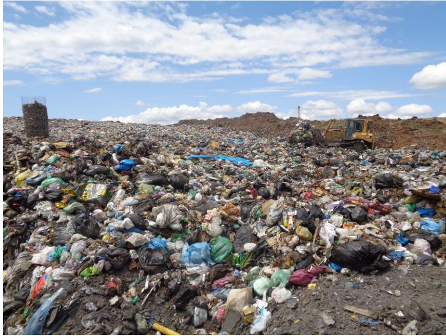
Figura 17. Frente de trabalho com equipamento de compactação e drenagem de gases. Não há presença de catadores
