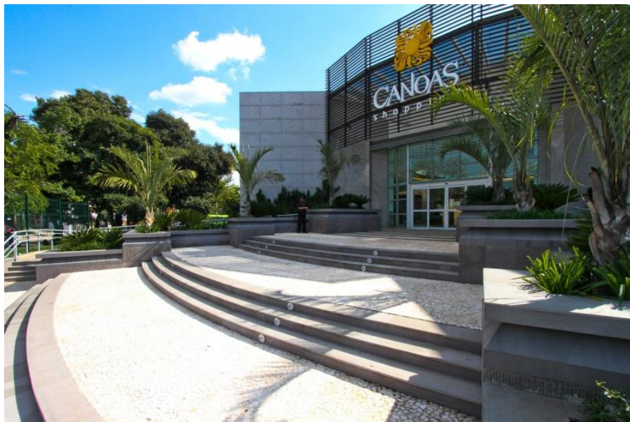
Figura 63 – Fachada do Canoas Shopping após a reforma
