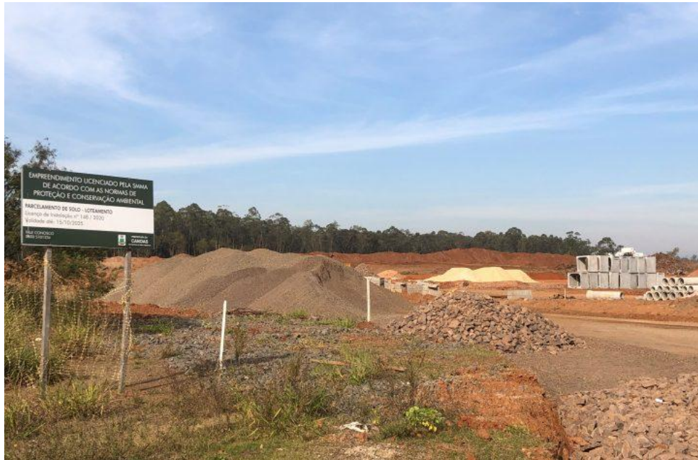
Figura 79 – Obras da loja Havan
