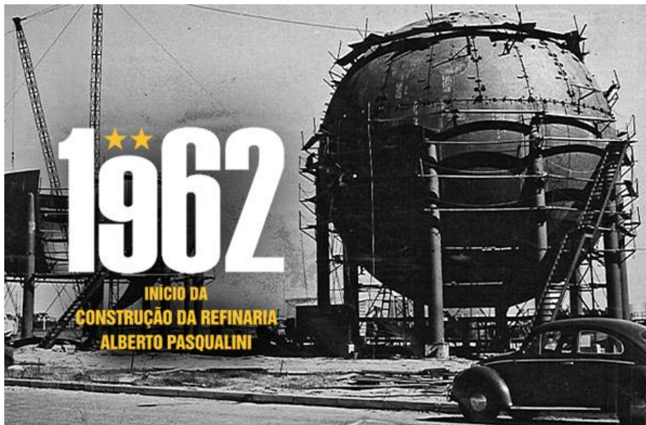
Figura 43 – Obras da REFAP iniciaram em 1962
