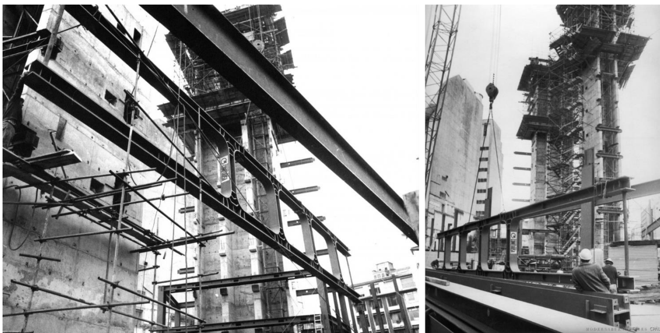
116 – fotos da construção do Edifício SOMISA – Imagens CPAU
