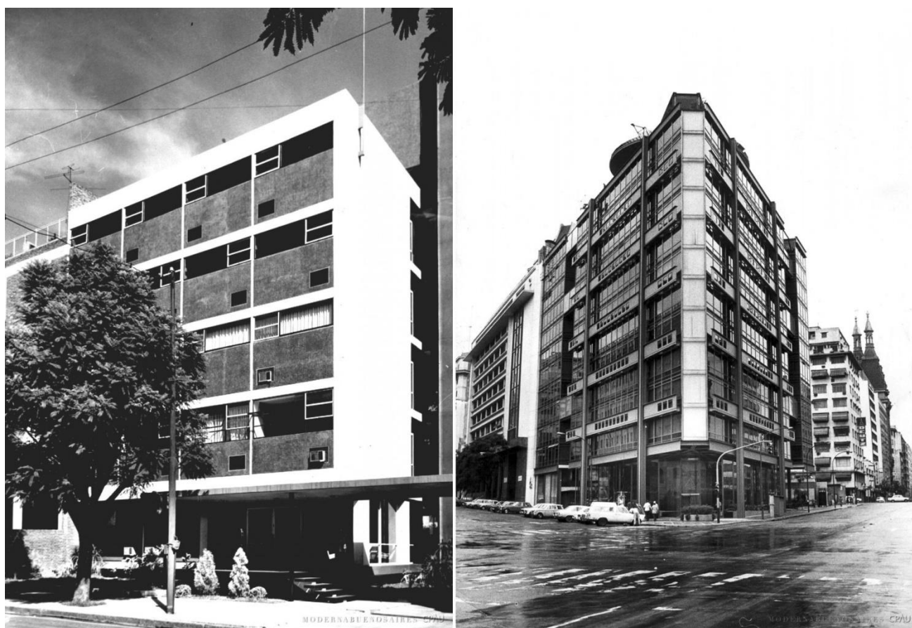
113 – Imagem da Clínica San Martín (a esquerda) e do Edifício Somisa (a direita) – Imagens CPAU
