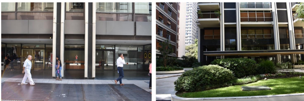
38 – Fotos dos pilares do Ed Bank of América (a esquerda) e do Edifício Panedille II (a direita)
