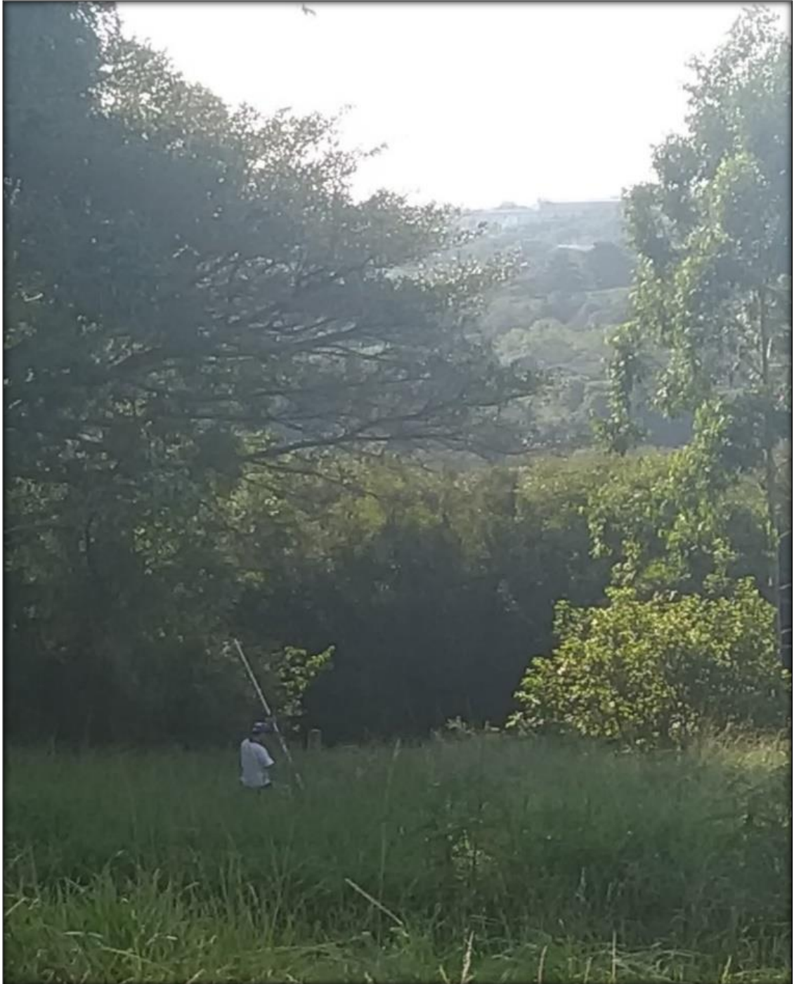
FIGURA M – Executando o caminhamento com o prisma para a tirada de visão pelo equipamento Estação Total Kolida KTS.
