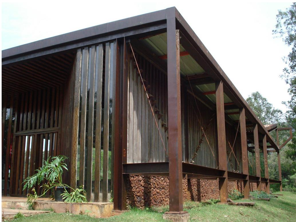
Figura 150 - Estrutura metálica formando beiral no exterior da Capela de Santana do Pé do Morro
