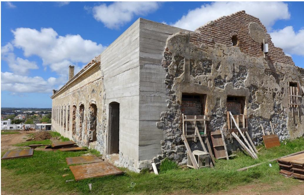
Figura 112 - Completamento de uma esquina do Centro de Interpretação do Pampa
