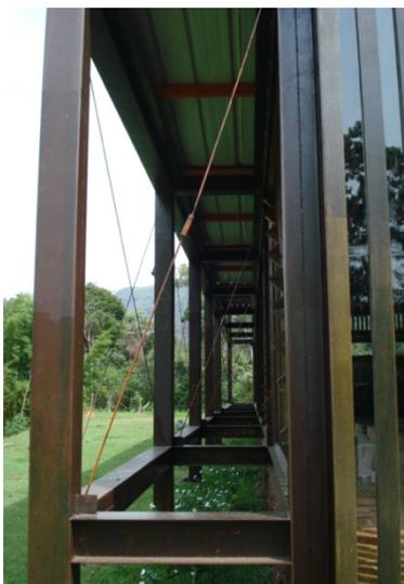
Figura 151 - Duplicação de pilares da fachada lateral da Capela de Santana
