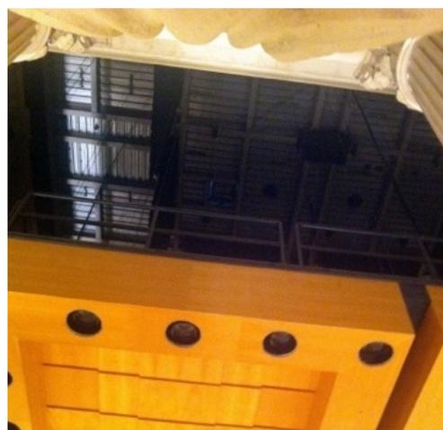
Figura 138 - Placa do forro móvel da Sala São Paulo mostrando a laje *steel deck* acima
