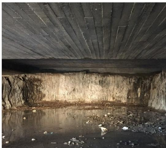
Figura 122 - Nova laje de piso CIP
