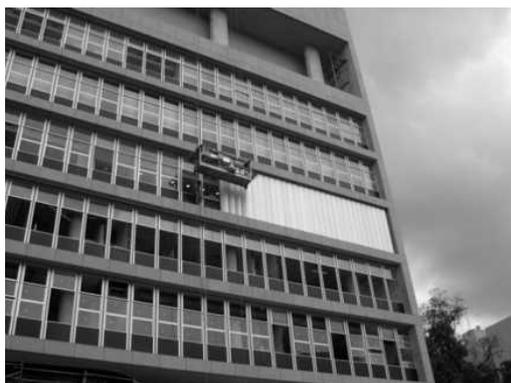
Figura 81 – Colocação dos brises na fachada oeste do Palácio da Justiça
