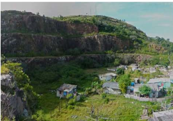
Fig. 5 - Cava de mineração desativada e ocupada irregularmente no Morro Santana.
