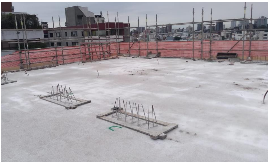
Figura 41 – Gualhos locados conforme projeto
