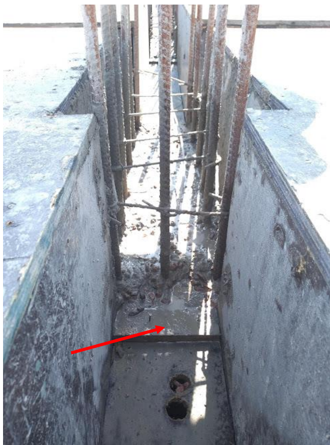
Figura 67 – Cota de parada do concreto
