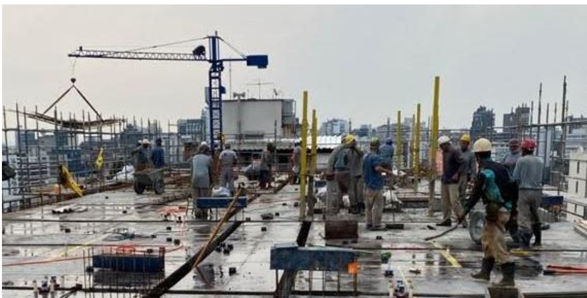
Figura 54 – Içamento das vigas pré-armadas através da minigrua
