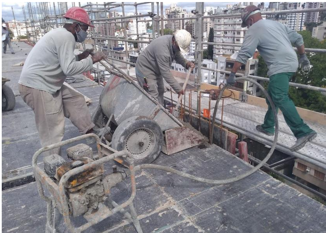
Figura 66 – Lançamento do concreto em base de madeira e adensamento com vibrador
