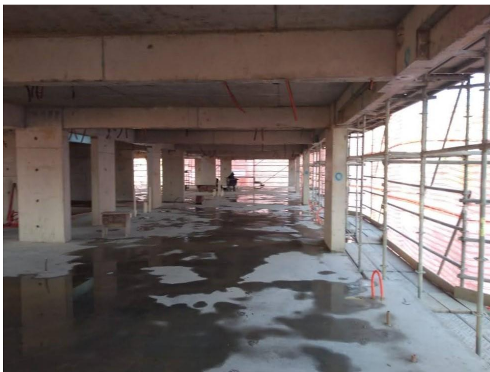
Figura 77 – Desforma total
