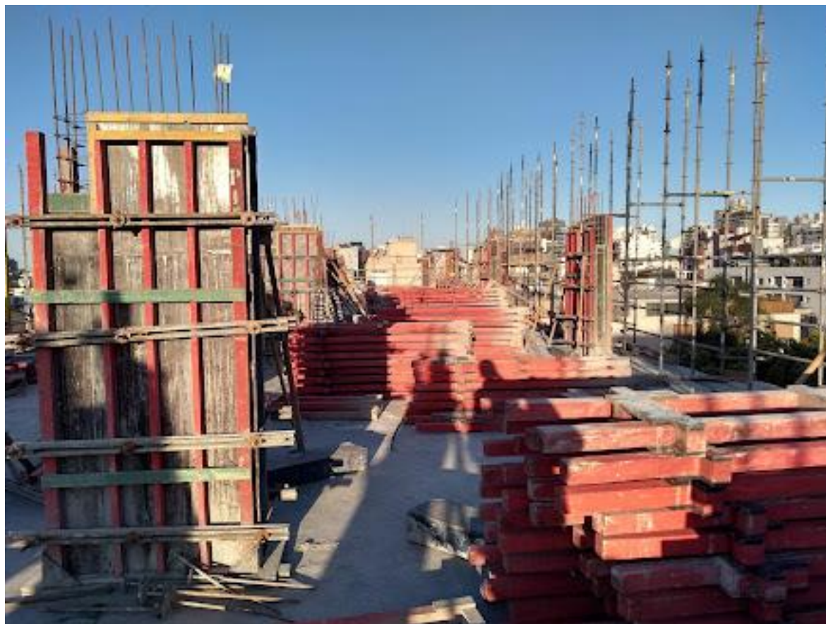
Figura 45 – Escoras das vigas posicionadas no pavimento
