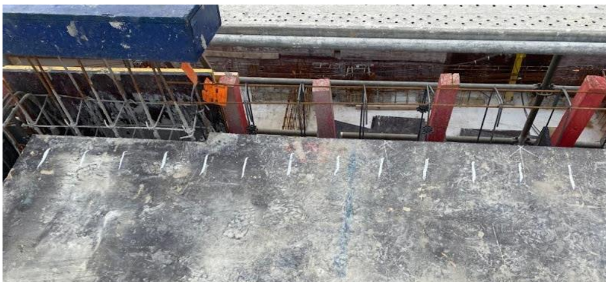
Figura 57 – Marcação da posição da armadura positiva
