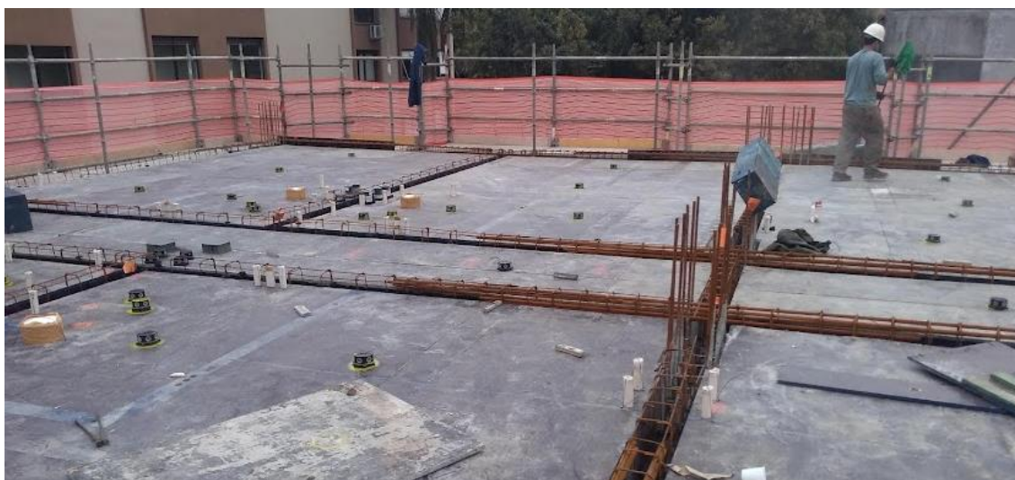
Figura 56 – Colocação das armaduras das vigas nas formas
