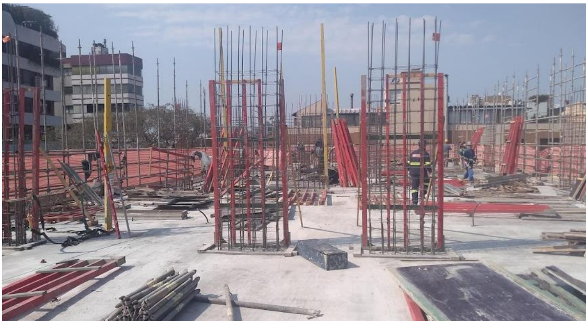
Figura 43 – Colocação das grades dos pilares
