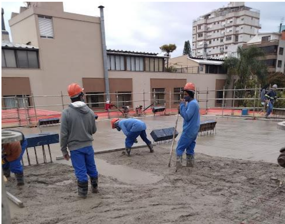
Figura 71 – Execução das mestras para posterior sarrafeamento
