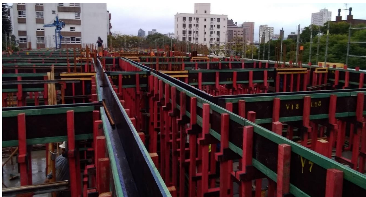
Figura 48 – Montagem dos painéis laterais das vigas
