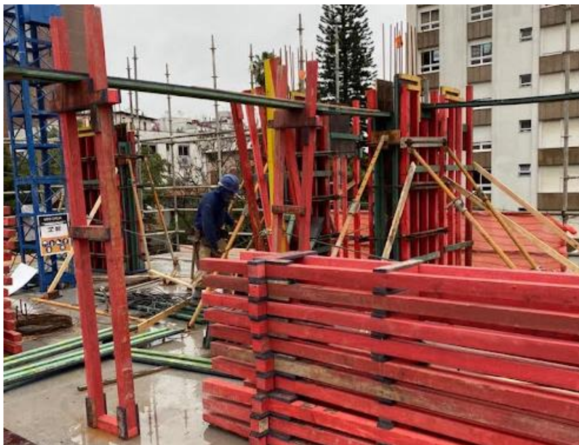
Figura 46 – Início colocação dos painéis de fundo das vigas
