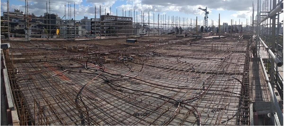
Figura 60 – Pavimento pronto para ser concretado – vista superior
