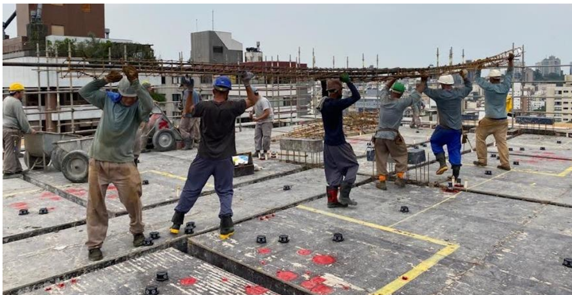
Figura 55 – Transporte das armaduras das vigas para a posição correta
