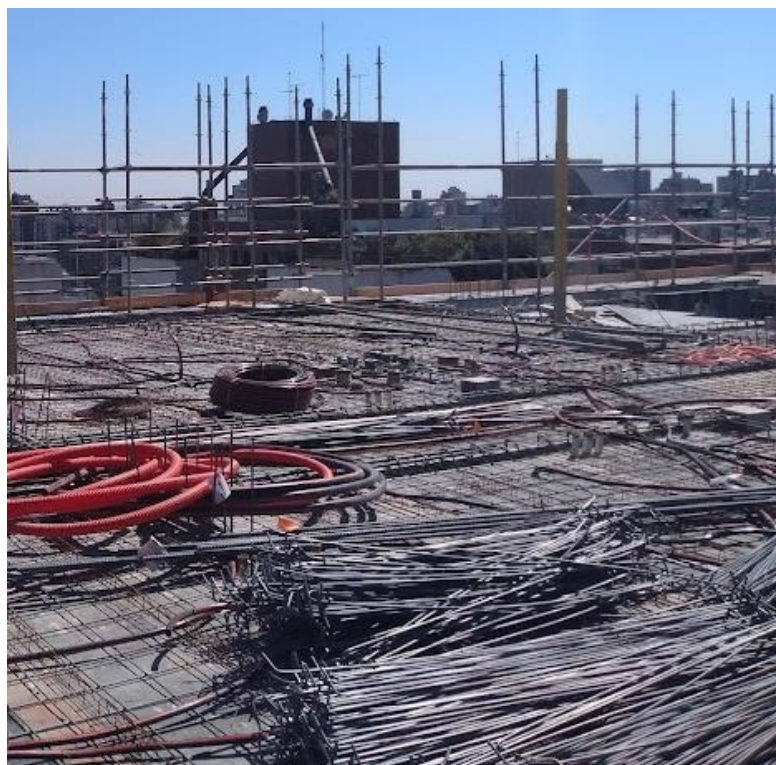
Figura 58 – Armadura negativa colocada no pavimento
