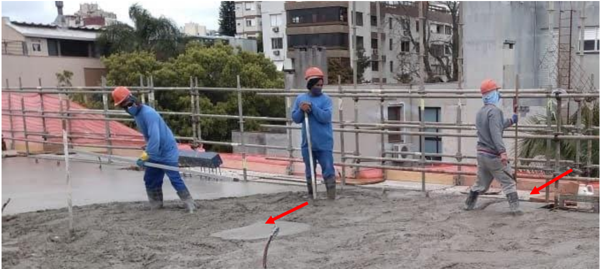
Figura 69 – Execução dos pontos de referência
