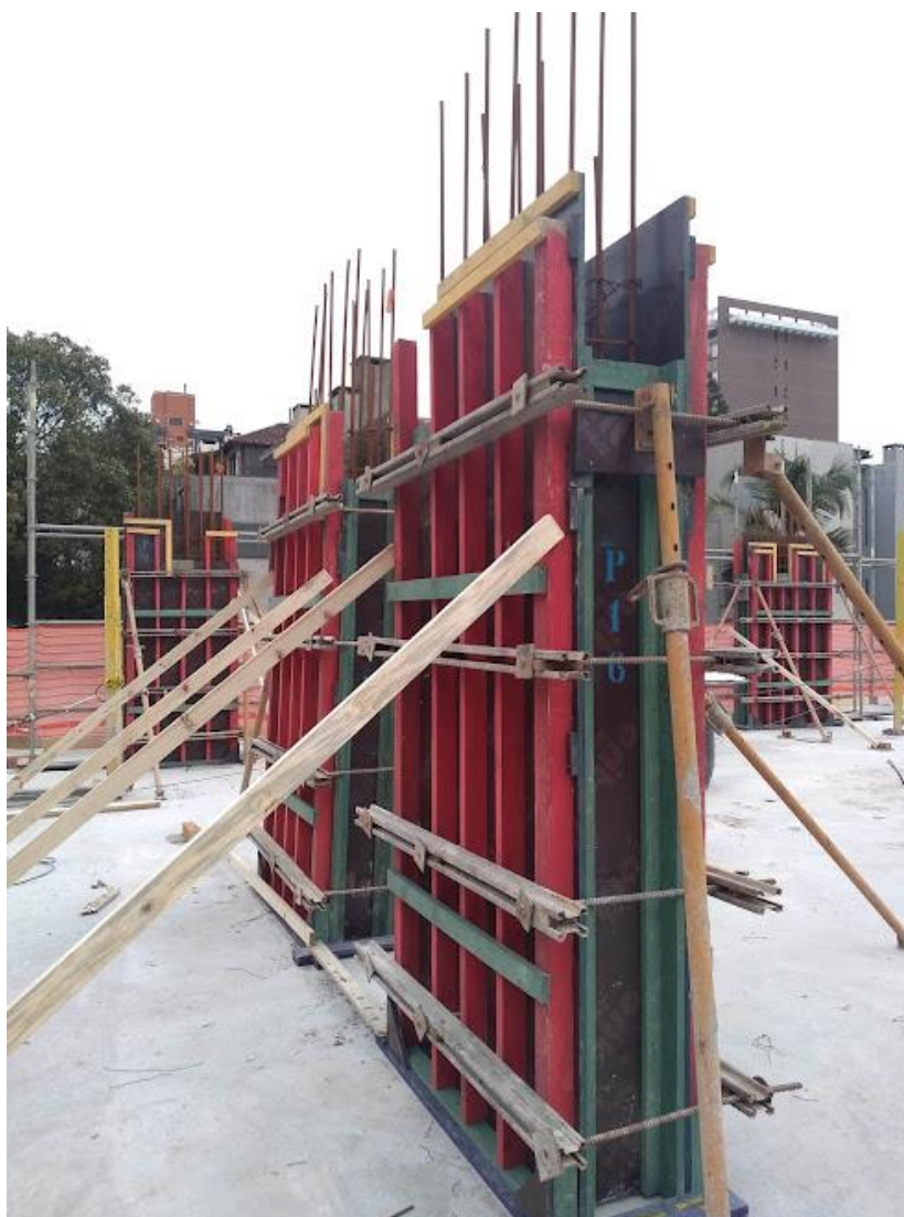
Figura 44 – Forma de pilar concluída
