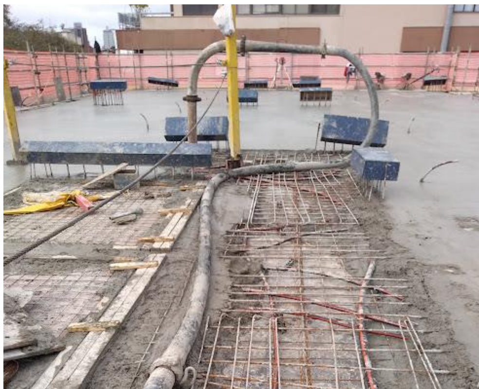
Figura 64 – Local da tubulação do concreto
