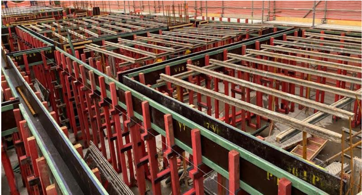
Figura 50 – Posicionamento das escoras e da estrutura de apoio para os painéis da laje (barroteamento)
