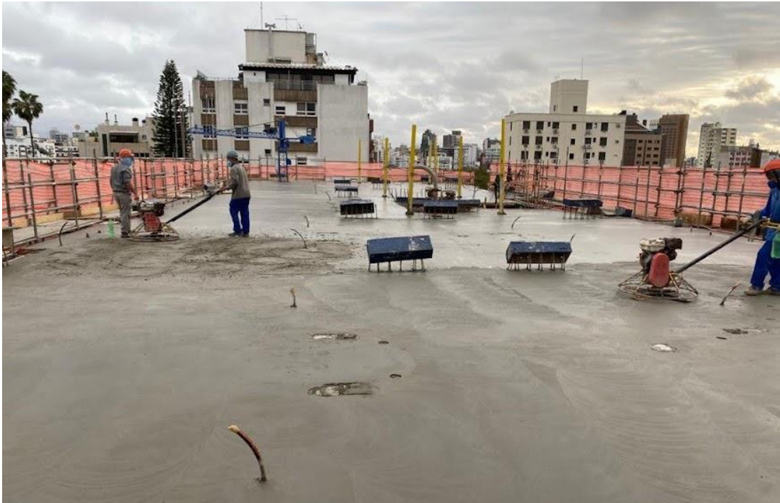
Figura 72 – Acabamento superficial da laje
