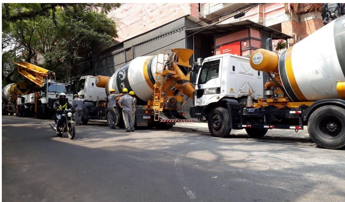
Figura 63 – Caminhões betoneira aguardando descarga e bomba posicionada
