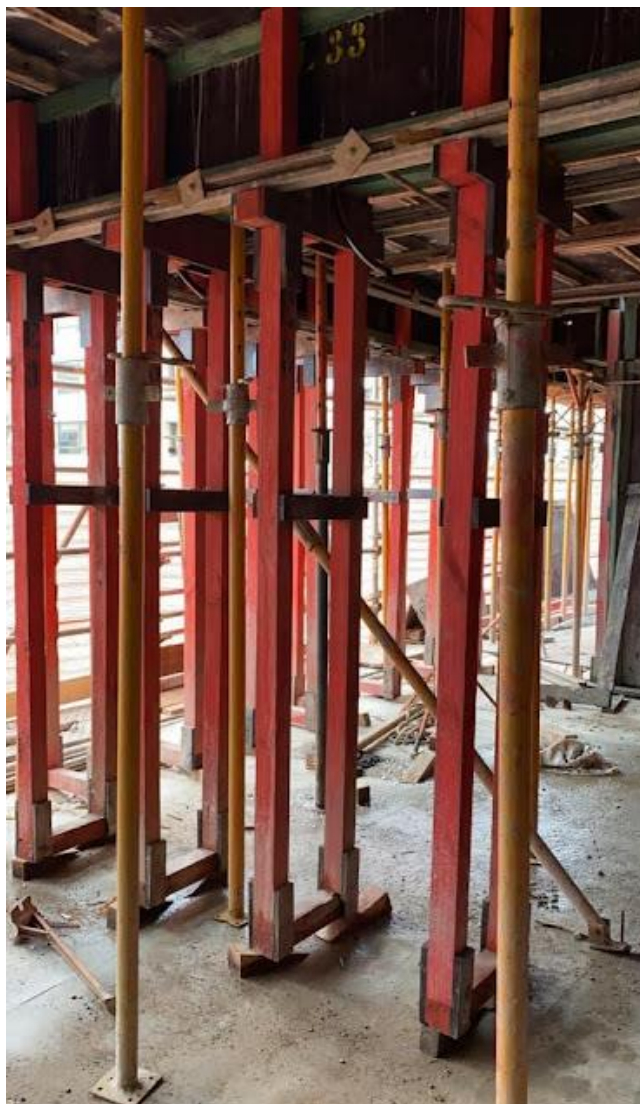
Figura 62 – Pavimento pronto para ser concretado – vista inferior
