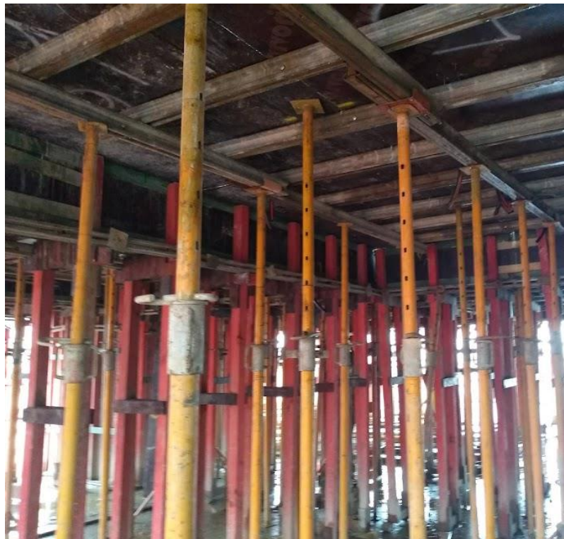
Figura 61 – Pavimento pronto para ser concretado – vista inferior
