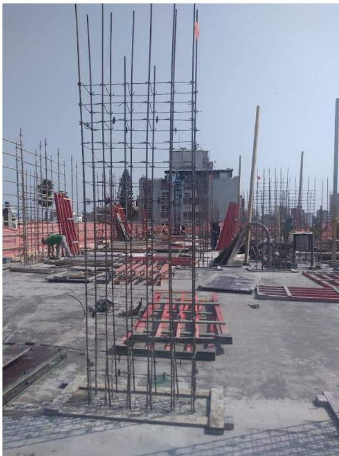
Figura 42 – Colocação da armadura dos pilares
