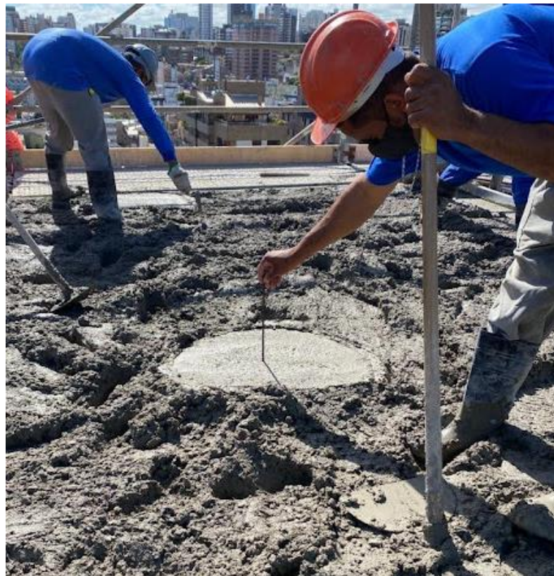
Figura 70 – Conferência da espessura da laje
