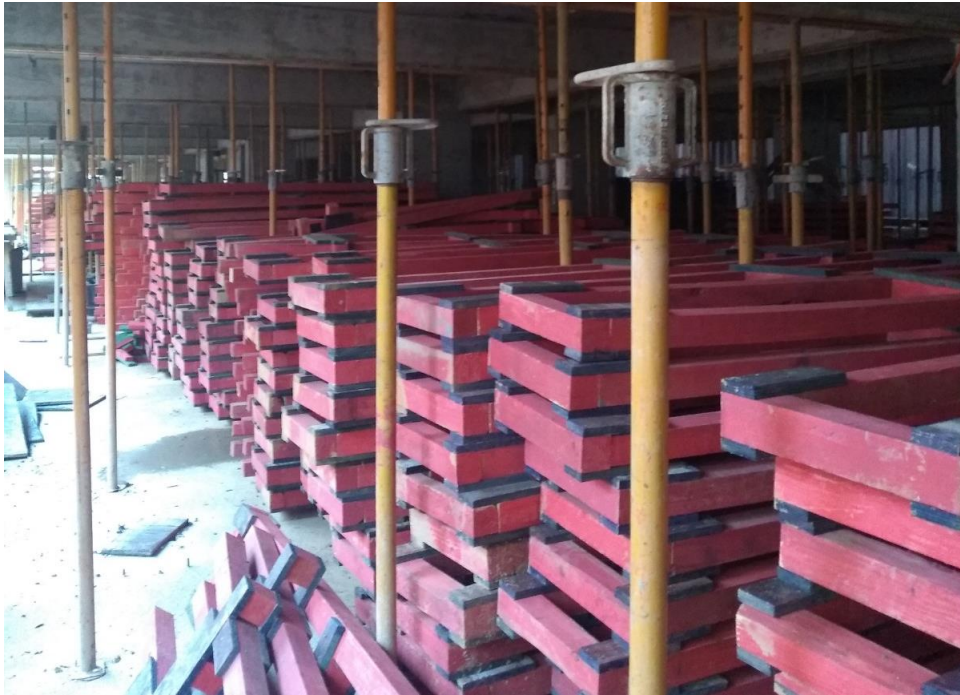
Figura 33 – Armazenamento das formas confeccionadas – escoras das vigas
