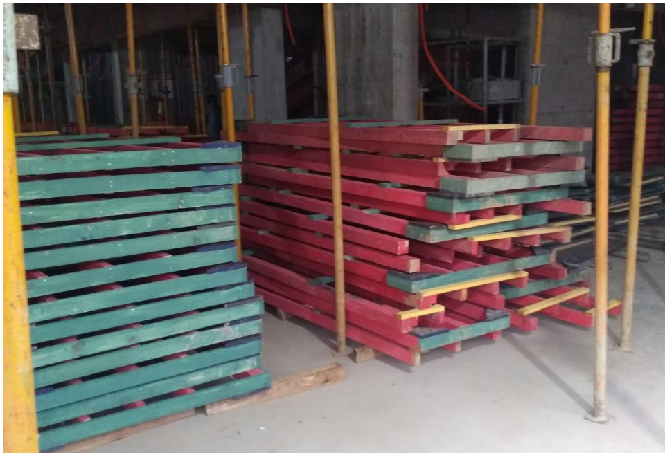
Figura 34 – Armazenamento das formas confeccionadas – grades de pilar
