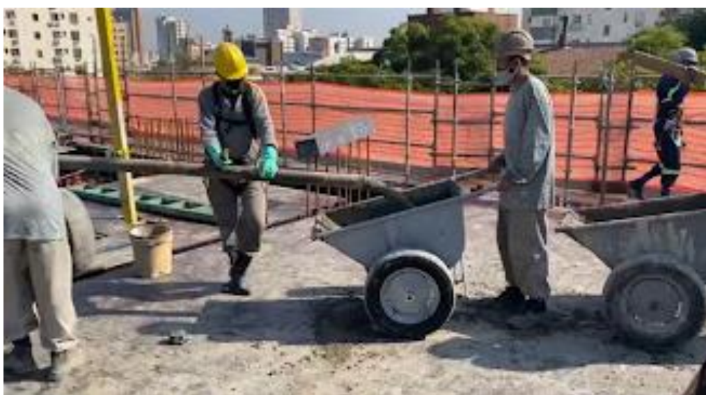
Figura 65 – Descarregamento do concreto na jericca
