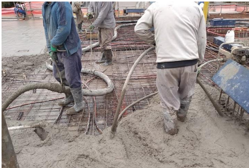
Figura 68 – Lançamento e adensamento do concreto
