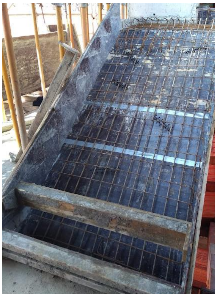
Figura 59 – Forma e armadura da escada
