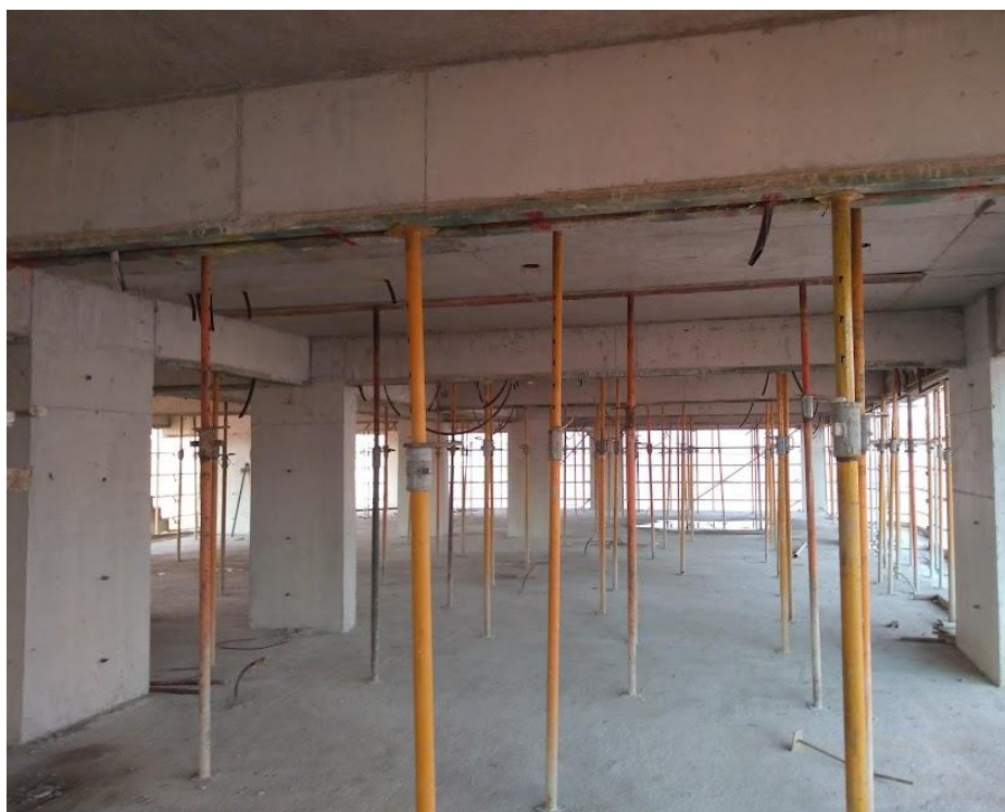
Figura 76 – Desforma parcial
