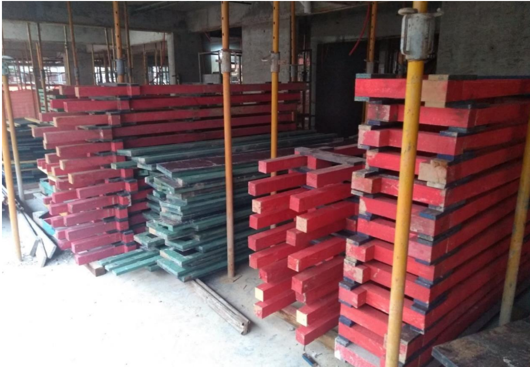
Figura 35 – Armazenamento das formas confeccionadas – escoras das vigas e painéis das vigas
