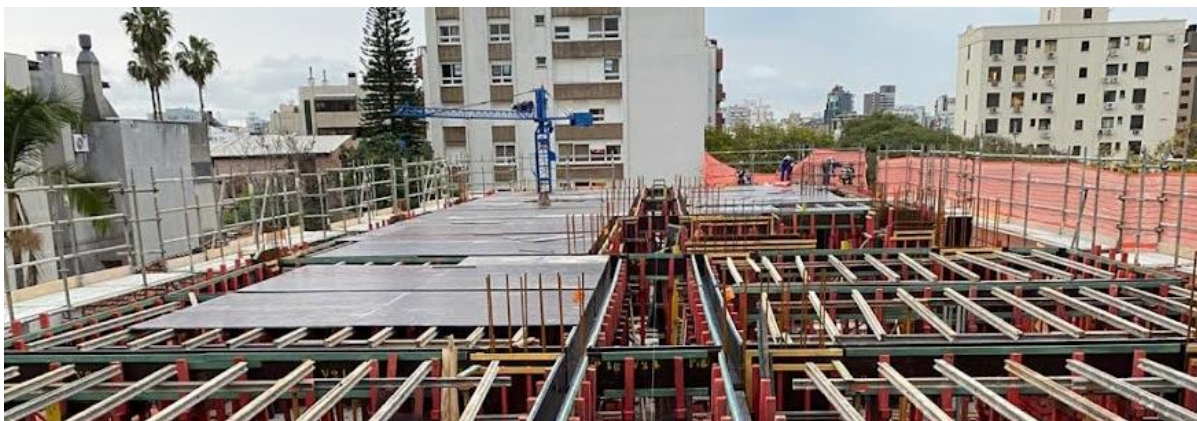
Figura 53 – Processo de assoalhamento da laje
