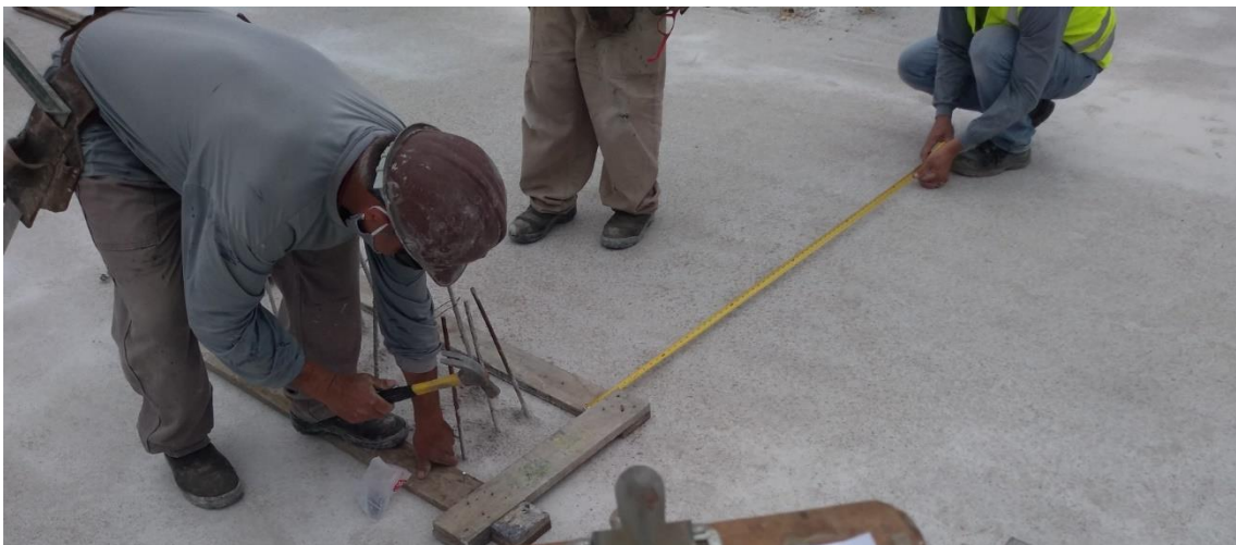
Figura 40 – Processo de marcação dos gastalhos
