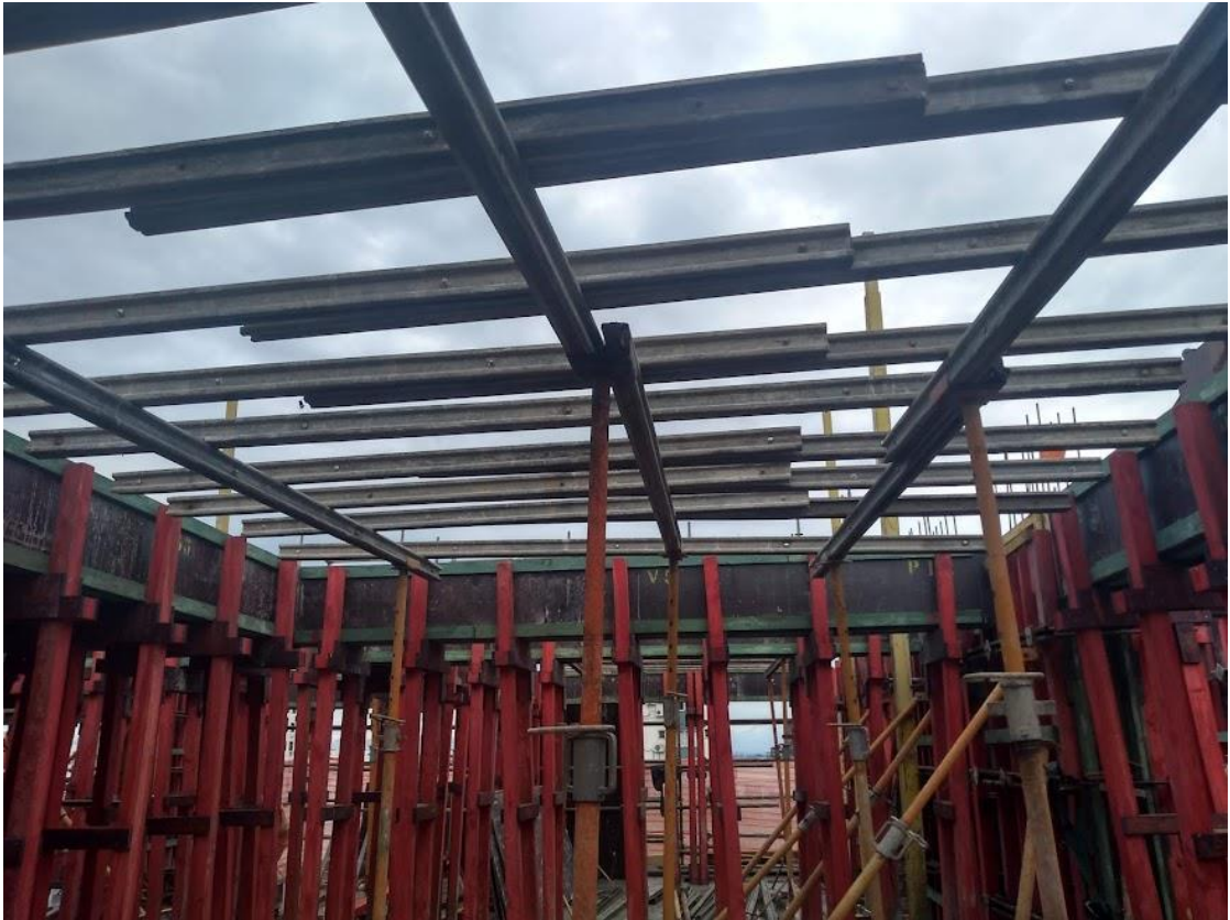
Figura 32 – Sistema de forma mista, tramada, com escoras de madeira e metálicas
