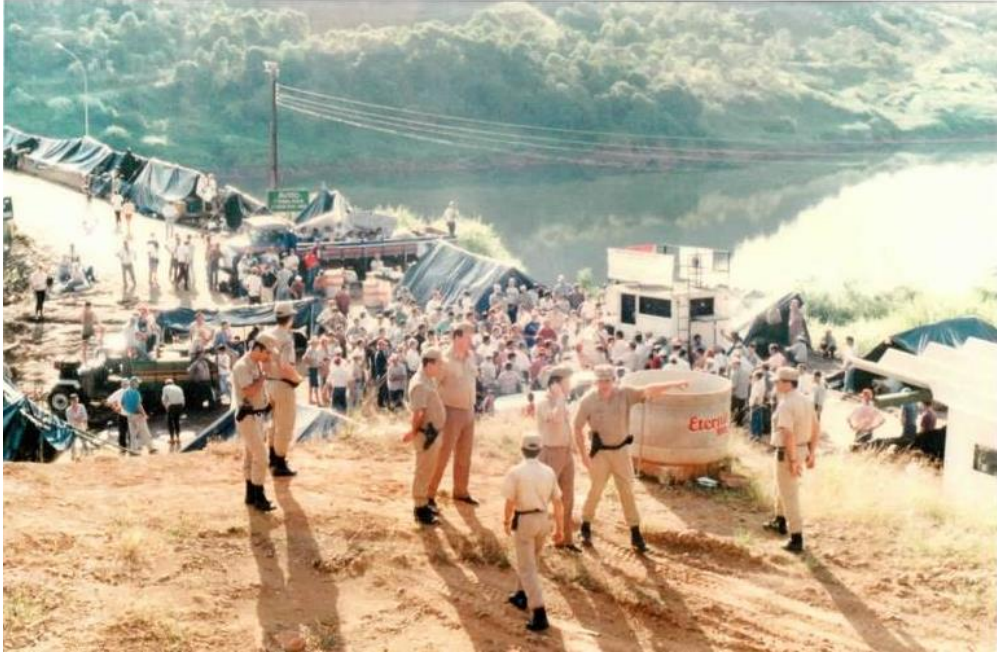
Figura 5 - Ocupação no canteiro de obras da barragem de Itá (1999)
