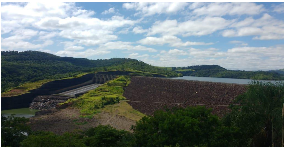
Figura 4 - Visão da parede da barragem de Itá
