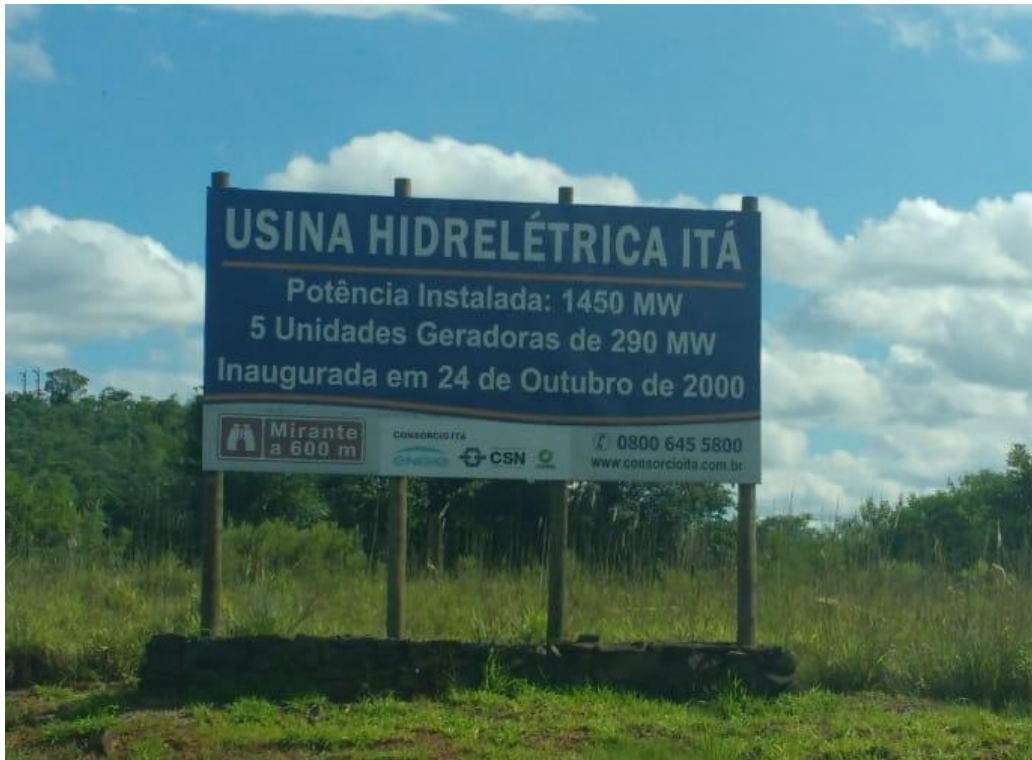
Figura 7 - Placa com informações próximo a barragem
