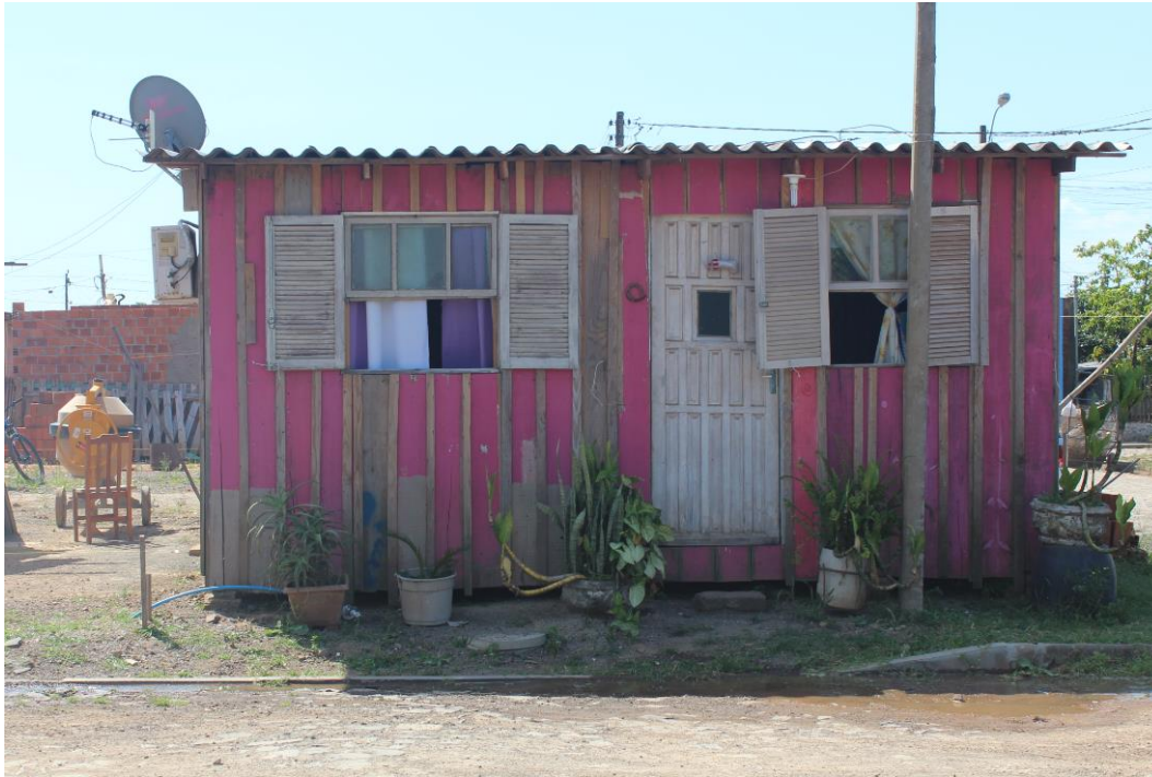
Figura 6. Perfil das habitações existentes na ocupação antes do processo de ATHIS
