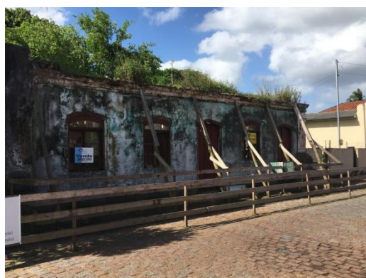
Figura 6 - Vista das edificações na área de entorno de Triunfo
