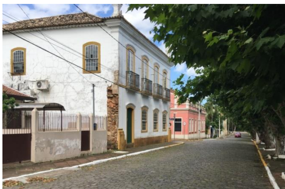
Figura 3 - Vista das edificações na área de entorno de Triunfo
