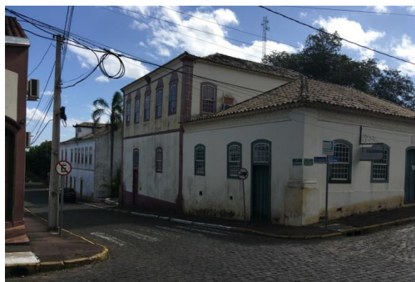
Figura 5 - Vista das edificações na área de entorno de Triunfo
