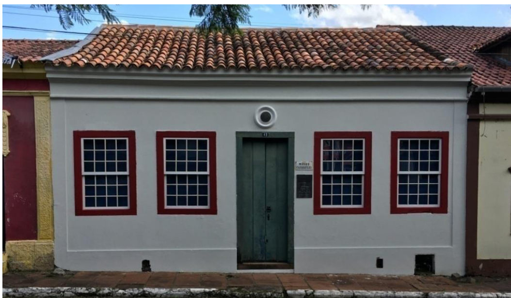
Figura 31 - Situação atual da Casa Tombada em Triunfo
