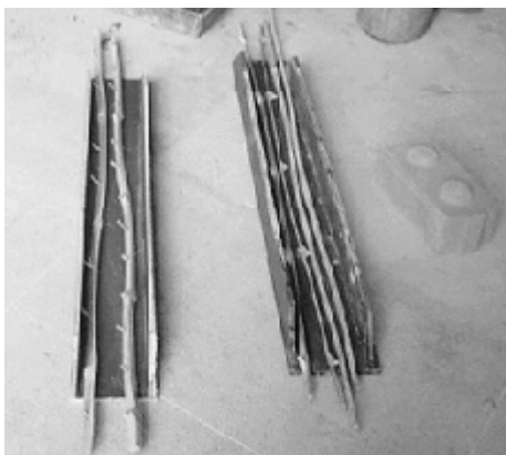
Figura 21 – Forma para verga pré-fabricada sobre portas e janelas, reforçada com bambu
