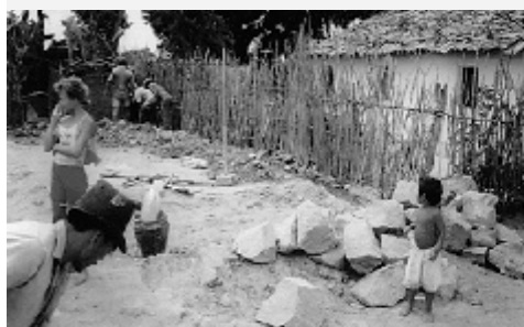
(e) Demolição de casa de taipa e pedras para fundação
