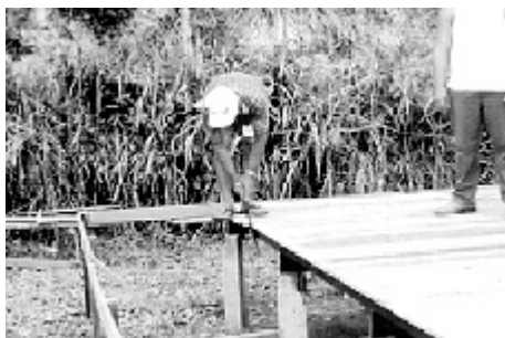
Figura 22 – Pilotis em concreto armado de seção triangular
