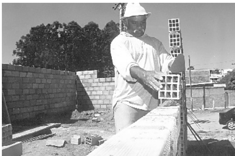
Figura 3 – Sosas: autoconstrutor realizando sua moradia
