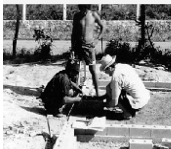
(g) Assentamento da primeira fiada de tijolos
