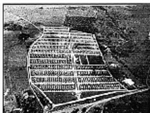
Etapa: Criação do tipo Cadastro: São João do Oitavo - São Paulo/SP Montagem do tipo.
