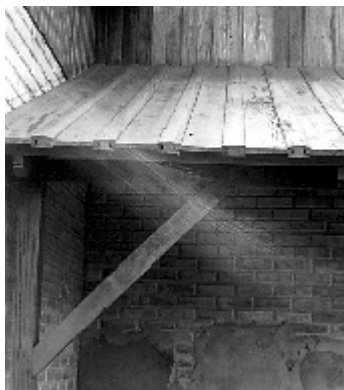
Figura 21 – Cobertura de madeira serrada
