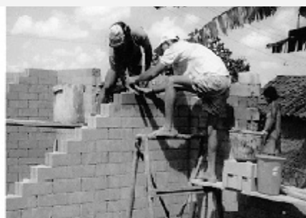
(h) Execução da alvenaria
