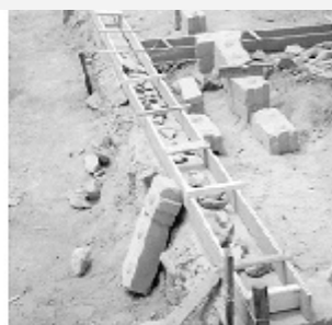
(f) Forma para primeira fiada em concreto
