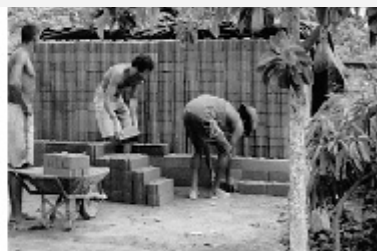
(d) Estocagem e cura com lona plástica
