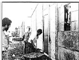
Etapa: Construção Cadastro: Babilônia - Curitiba/PR Montagem das paredes e fixação dos elementos.
