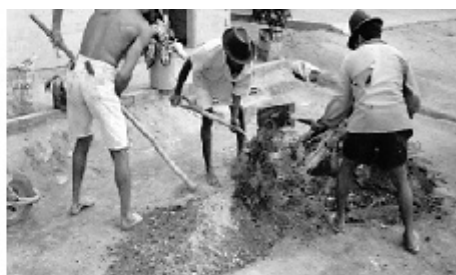
(b) Mistura da terra com o cimento e a água
