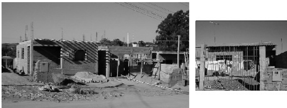
Figura 12 – Projeto TITAM: moradias autoconstruídas
