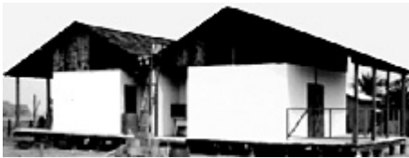
Figura 20 – Protótipo de casas geminadas construídas com cobertura de cavaco
