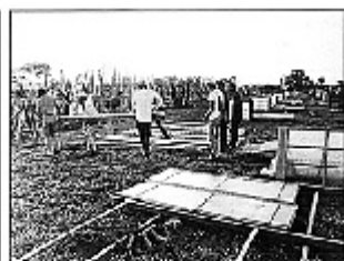
Etapa: Construção Cadastro: Jardim da Glória em São Paulo Construção de uma casa com muitos apartamentos.
