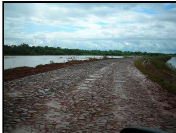
Figura 21. Condição prévia da estrada projeto
