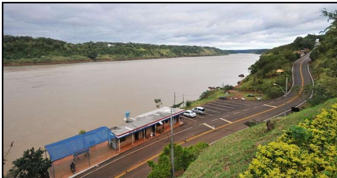
Figura 18. Melhoramento da via próxima da tríplice fronteira
