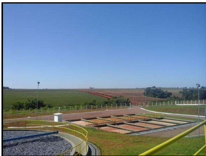
Figura 29. Sistema de esgoto de Ponta Porã desenvolvido por projeto do Focem
