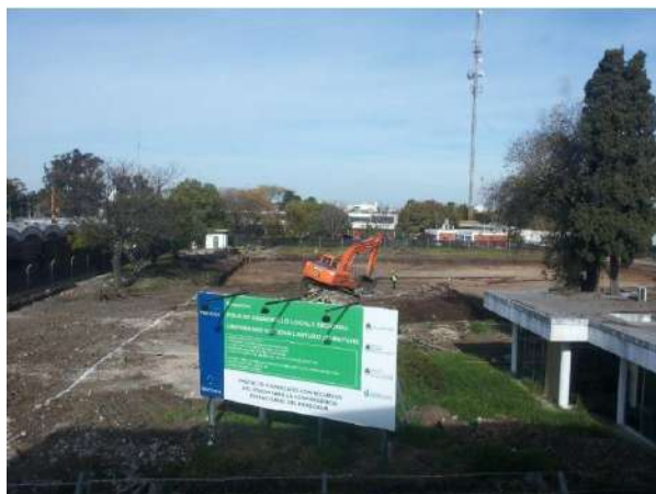
Figura 38. Obras na Universidade Nacional de Arturo Jauretche
