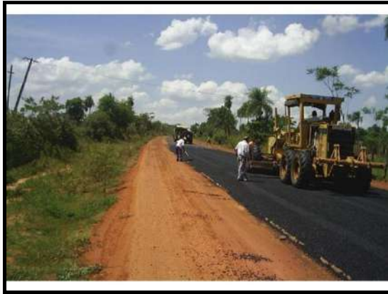
Figura 19. Recapeamento de estrada.
