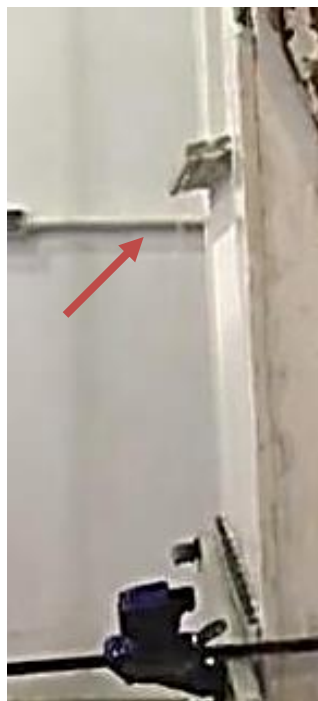
Figura 22 – Foto do fluxo de escoamento da chuva observado pela lateral da parede no ensaio de chuva dirigida
