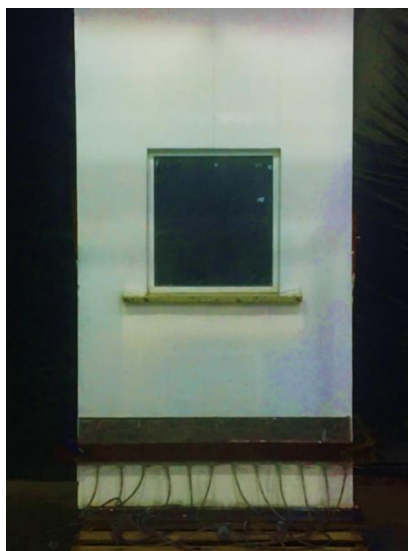
Figura 9 - Parede após ensaio de chuva colorida
