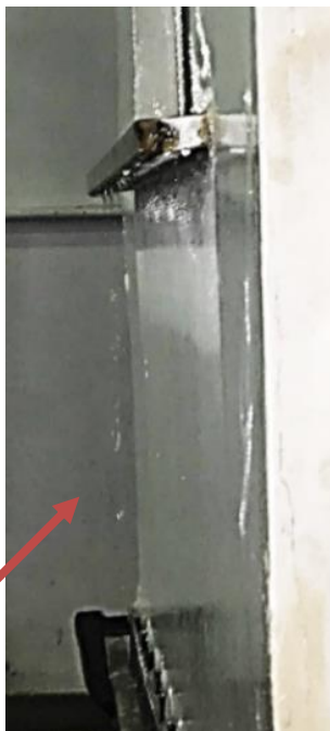
Figura 14 – Foto do fluxo de escoamento da chuva observado pela lateral da parede no ensaio de chuva dirigida
