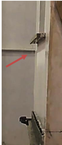
Figura 6 – Foto do fluxo de escoamento da chuva observado pela lateral da parede no ensaio de chuva dirigida
