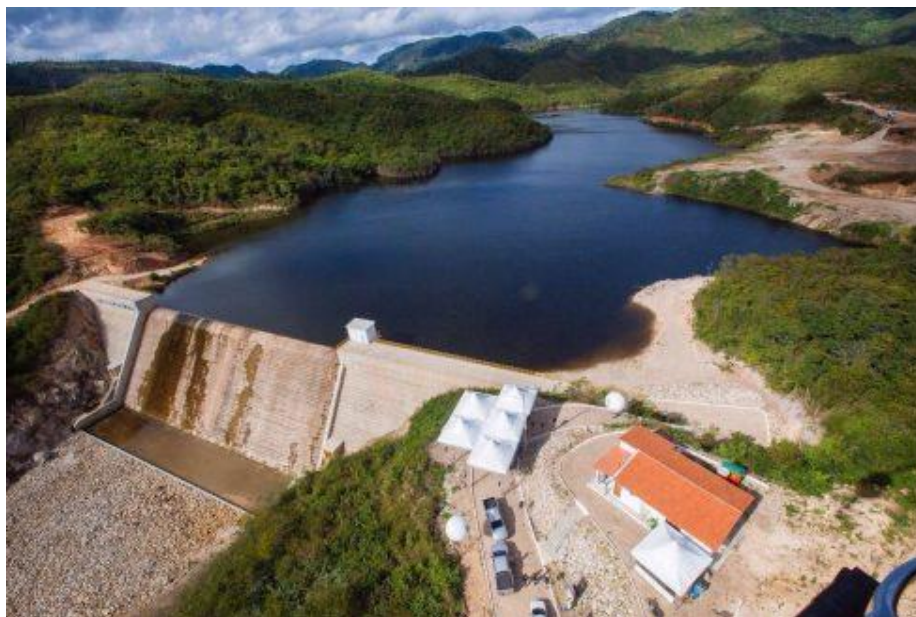
Figura 14. Reservatório em Fortaleza, CE (Fonte: GOVERNO DO ESTADO DO CEARÁ, 2020).
