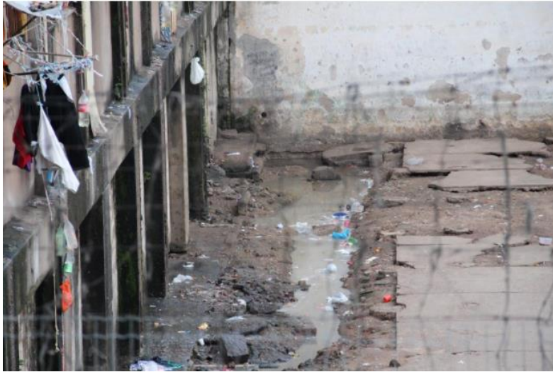
Figura 3 – Resíduos e efluentes despejados a céu aberto
