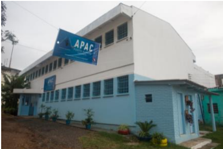
Figura 5 – Fachada do prédio da APAC Partenon
