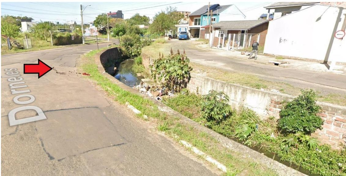
Figura 13 - Assoreamento e Solapamento no Arroio Passinhos. Fonte: Google Street View. Elaborado por: Autor (2021)
