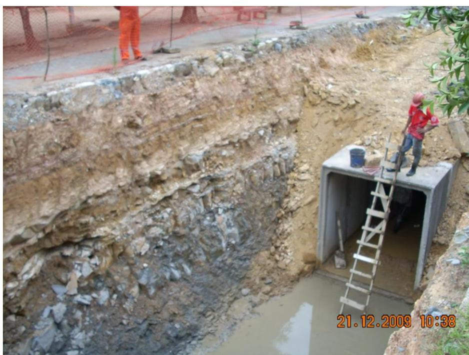
Foto 5 - Construção do Conduto Forçado. Fonte: Prefeitura de Cachoeirinha – RS, 2009.
