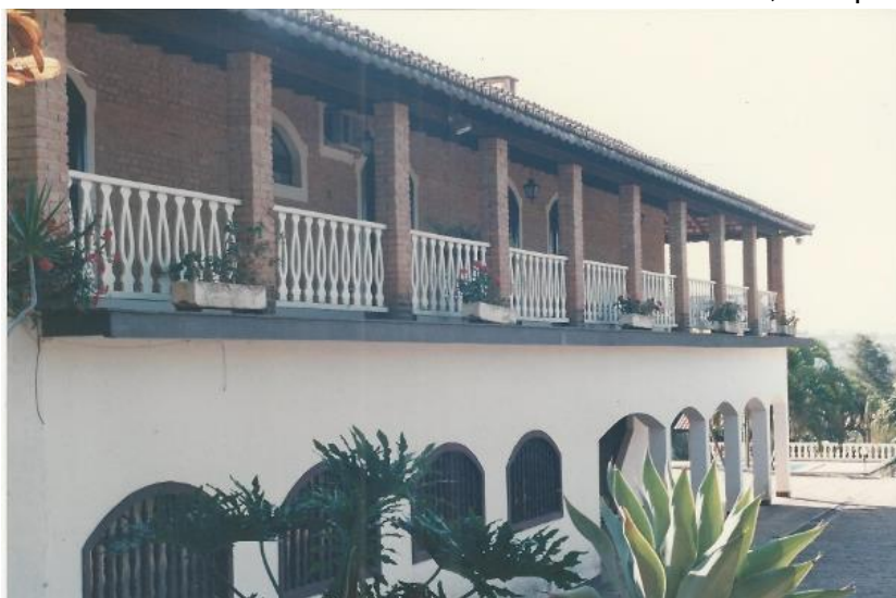
Figura 15 – Centro de Treinamento do SAAD em Indaiatuba, Campinas (SP)
