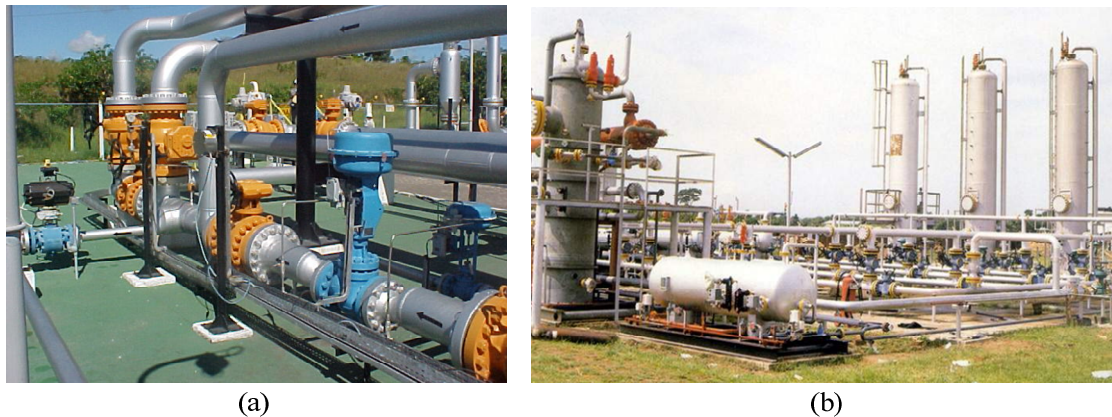
Figura 2.7: Exemplo de válvulas e atuadores utilizados em refinarias e terminais. (a) válvulas para controle de fluxo em dutos e (b) a grande quantidade de válvulas utilizadas apenas em uma parte da refinaria.
