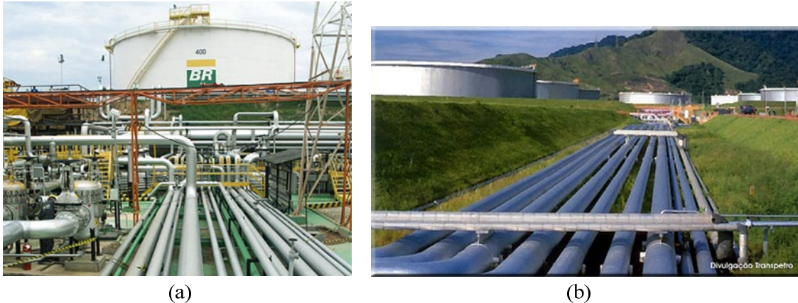
Figura 2.6: Exemplos dos dutos dentro de uma refinaria. (a) Transporte interprocessos de refino e (b) abastecimento de uma refinaria.
