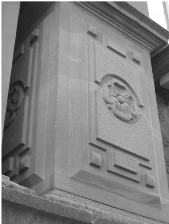
Figura 3 - Detalhe de laminação plano-paralela dos arenitos da fachada do Museu Júlio de Castilhos.
