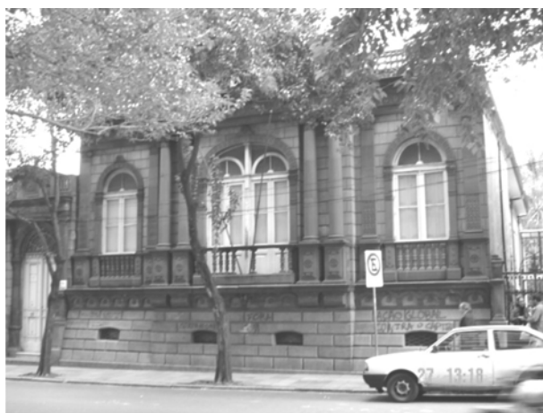
Figura 1 - Vista geral da fachada do Museu Júlio de Castilhos.
