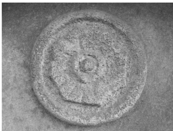
Figura 12 - Detalhe da roseta central da figura anterior evidenciando a perda de material por alteração intempérica.
