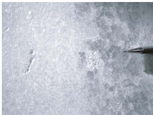
Figura 5 – Aspecto geral das chapas de mármore do revestimento da Cúpula ressaltando a textura granoblástica grossa e o início da dissolução de cristais de calcita.
