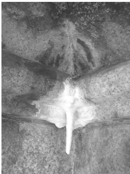
Figura 8 – Estalagmite composto por cimento carbonático hidratado originado a partir da dissolução e precipitação do cimento de fixação das chapas da Cúpula.
