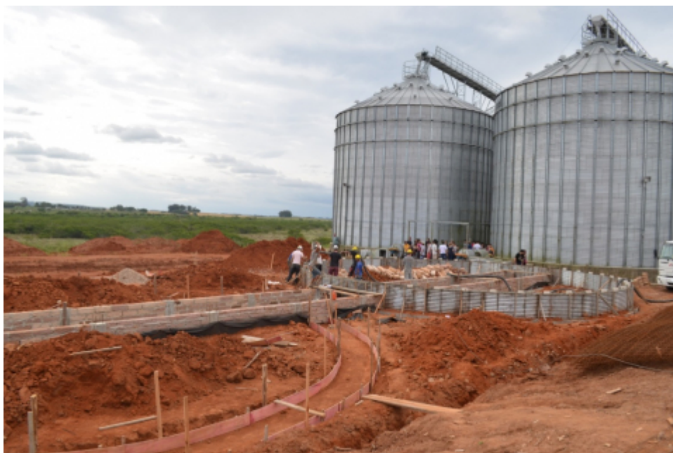
Figura 2 - Obras de ampliação da Unidade de Beneficiamento de Sementes da COTAP – Assentamento Lanceiros Negros, Eldorado do Sul, Rio Grande do Sul
