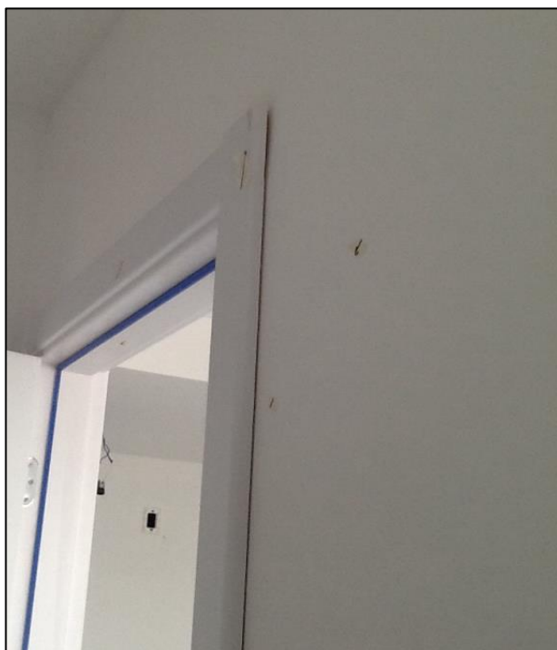
Figura 21 – Fresta não-uniforme na lateral da guarnição
