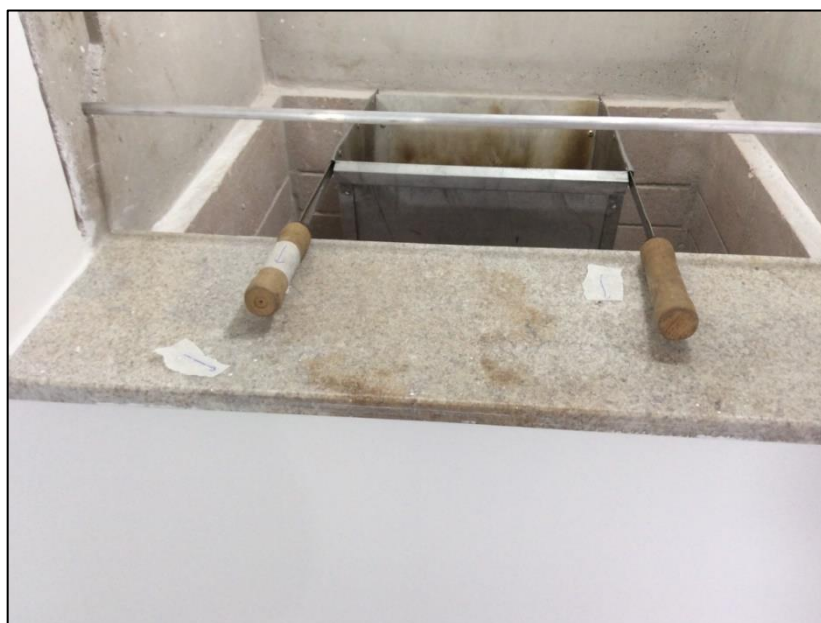
Figura 26 – Manchas em granito do tipo Itaúnas
