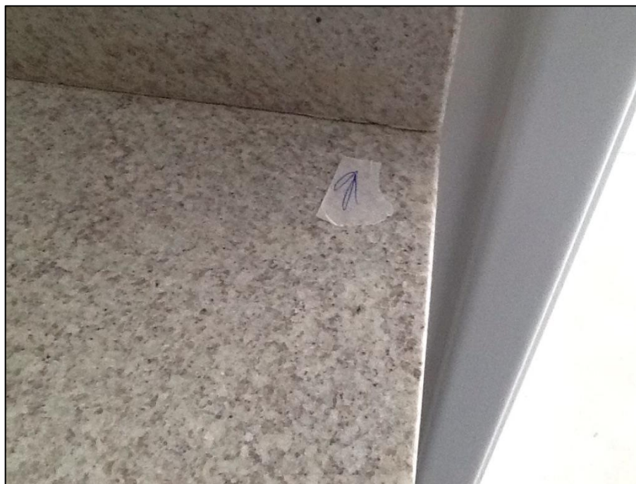
Figura 24 – Falha na vedação entre peças do tampo de granito
