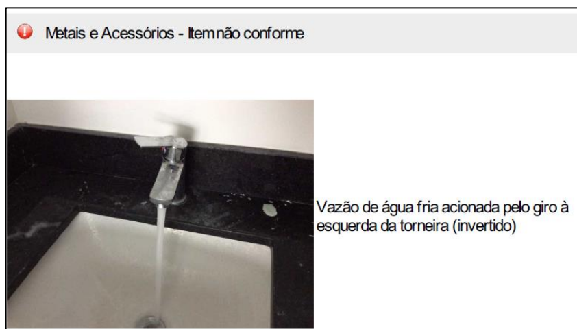
Figura 14 – Exemplo de ocorrência de instalação hidráulica
