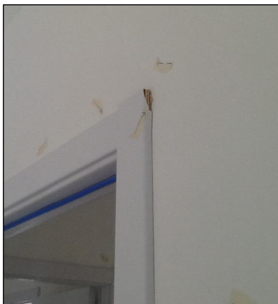
Figura 22 – Guarnição de porta com lasca no canto
