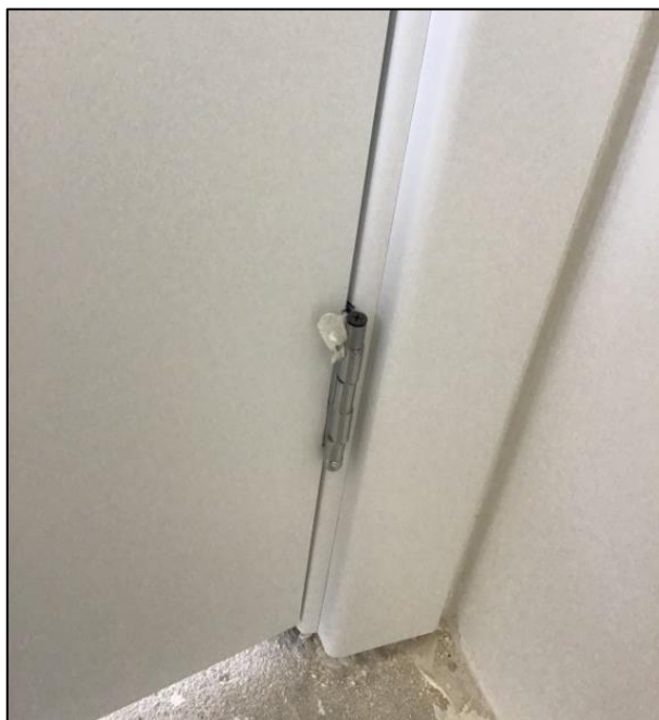
Figura 20 – Dobradiça desregulada por falta de pino de ligação
