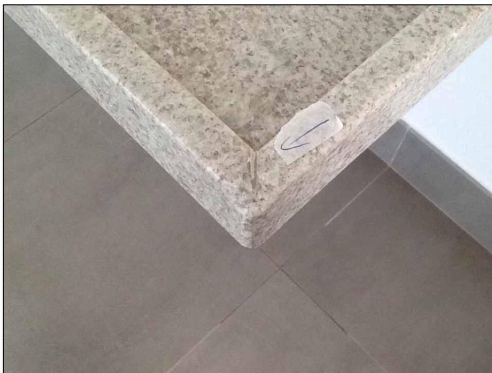
Figura 25 – Tampo de granito com lasca no canto vivo
