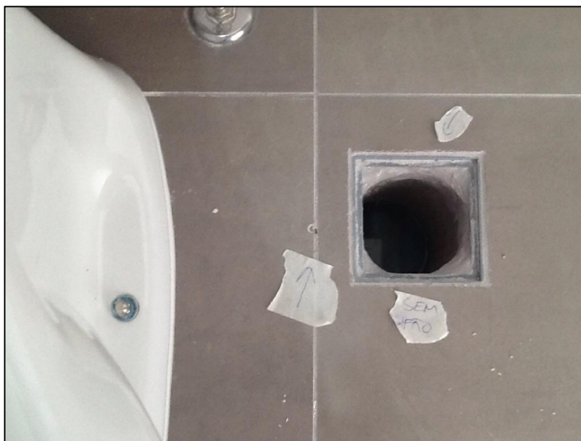
Figura 19 – Exemplo de ocorrência de lasca na cerâmica
