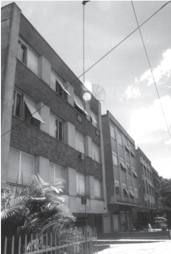
9 Edifícios gabaritados pela lei n.º 2330. Rua Dr. Vicente de Paula Dutra, Porto Alegre. Década de 60. Foto do autor
