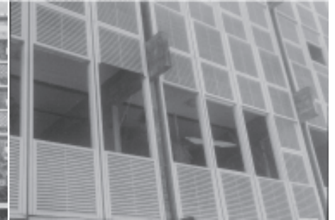
7 Ed. FAM. Detalhe da fachada venezianada. Foto do autor
