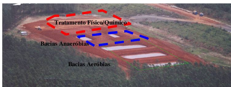
Figura 5 - ETEL Vista Geral
