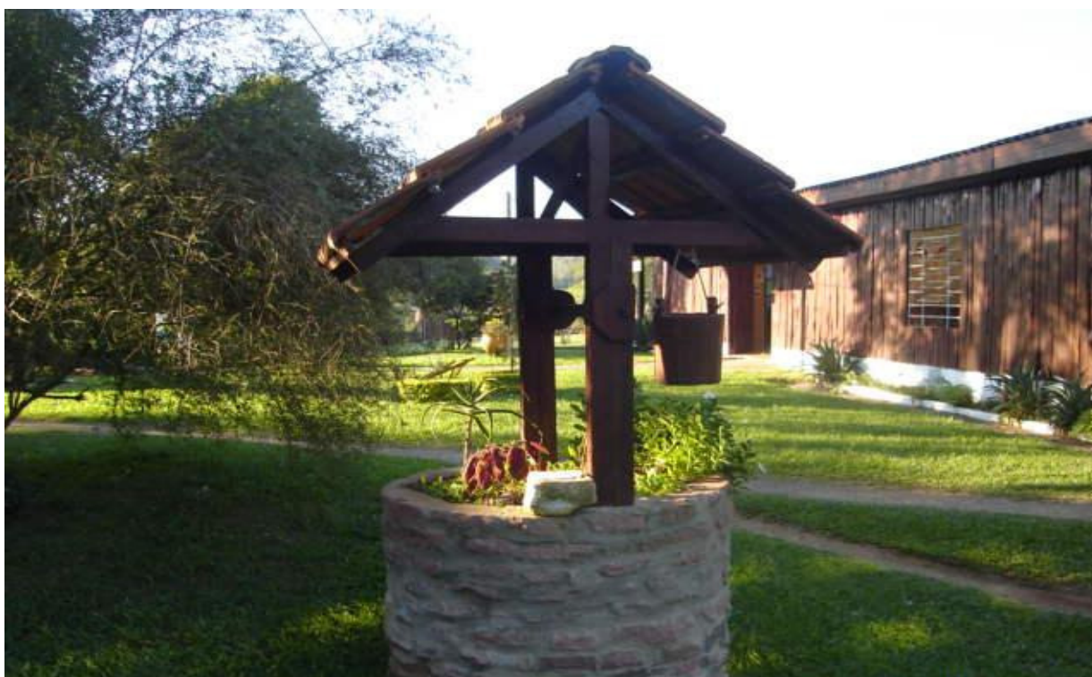
Figura 3: Foto da utilização da madeira na estrutura do poço artesiano
