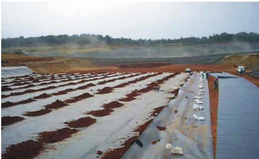
Figura 5 – Aterro Sanitário da SIL – Impermeabilização do Solo
