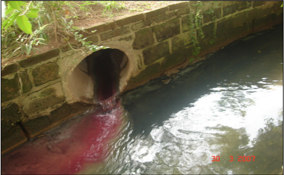
Figura 9 – Poluição das Águas do Arroio Estância Velha – 03/2007 Fonte: SEMAPE
