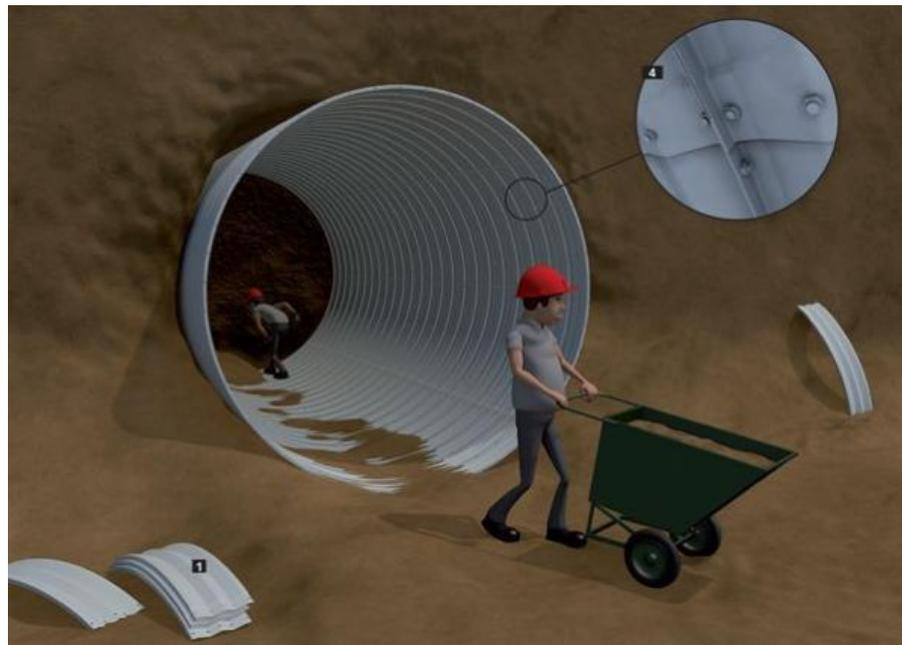
Figura 16 Escavação do túnel liner (ARMCO STACO; 2018)
