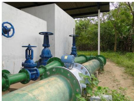
Figura 3.18: sistema de alimentação do modelo 1:50
