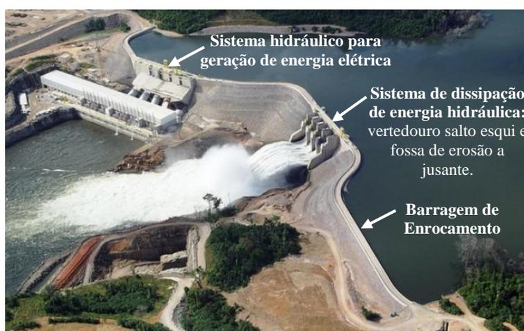
Figura 1.1: sistemas hidráulicos de geração e dissipação de energia da Usina Teles Pires, com primeira unidade de geração inaugurada em 2015 - MT/Brasil. Fonte: CliqueNotícias<sup>1</sup>
