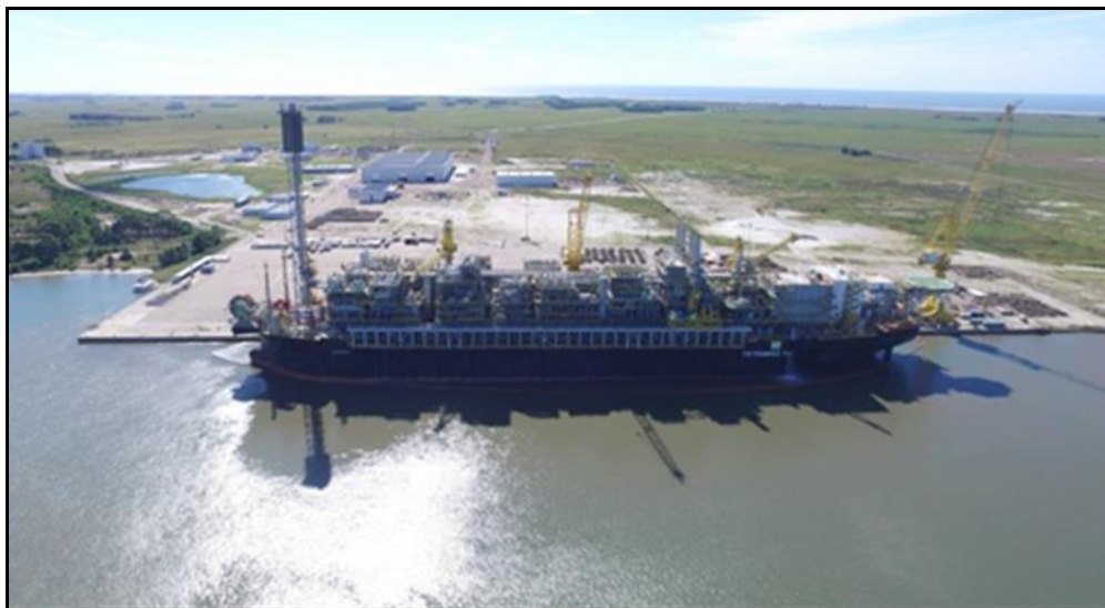
Figura 11 - Plataforma P-74 no estaleiro EBR – São José do Norte
