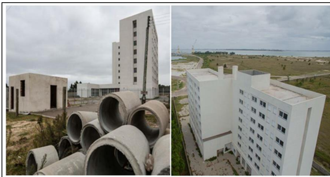
Figura 22 - Obras da rede Swan Hotels em São José do Norte
