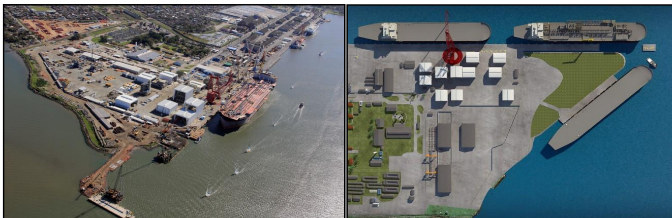
Figura 7 - Ampliação do Cais do Estaleiro Honório Bicalho – Rio Grande/RS
