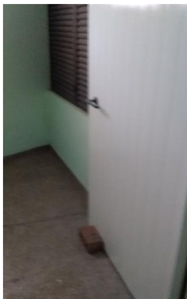
Figura 08 – Porta de escada enclausurada mantida aberta.
