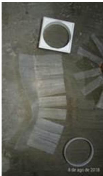
Figura 60 - Corte da tela estruturante para o ralo
