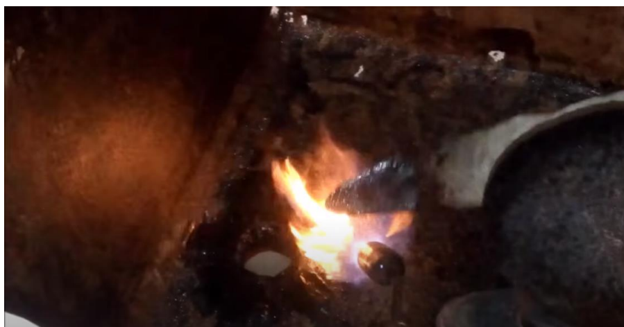
Figura 64 - Impermeabilização do ralo com manta asfáltica
