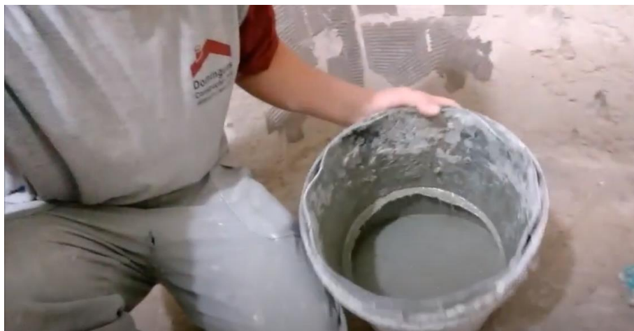
Figura 81 - Mistura pronta para aplicação
