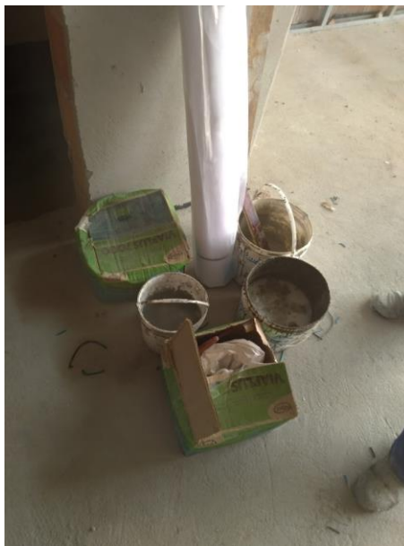
Figura 23 - Materiais utilizados para impermeabilização com argamassa polimérica
