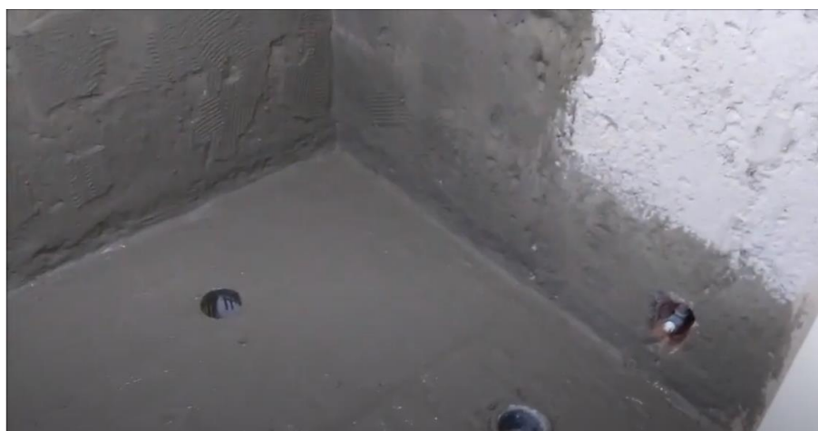
Figura 83 - Finalização da impermeabilização
