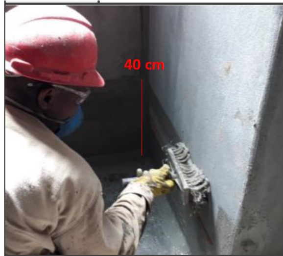
Figura 50 - Aplicação do impermeabilizante na parede
