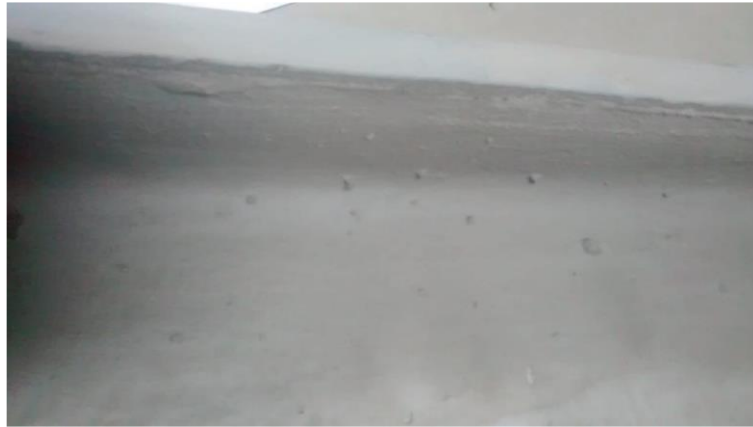
Figura 55 - Aresta com meia cana sem apresentar fissuras
