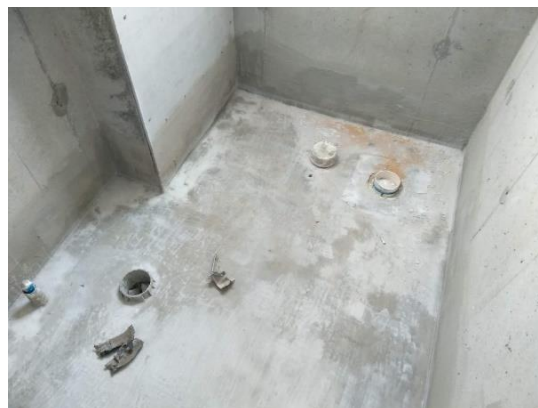
Figura 59 - Área impermeabilizada
