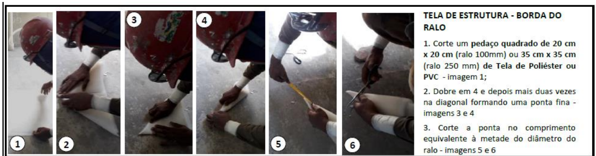
Figura 39 - Instrução para corte da tela estruturante posicionada na borda do ralo
