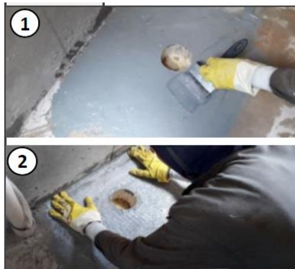
Figura 43 - Aplicação da primeira camada de impermeabilizante e da tela estruturante
