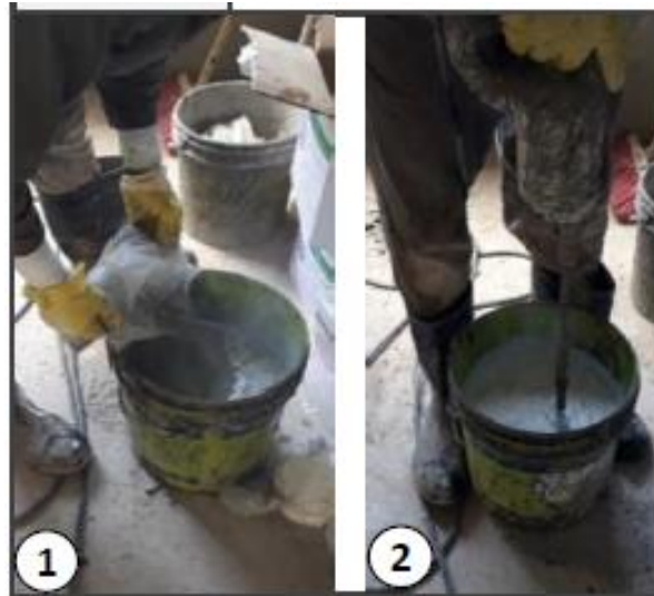
Figura 41 - Preparação da mistura do impermeabilizante
