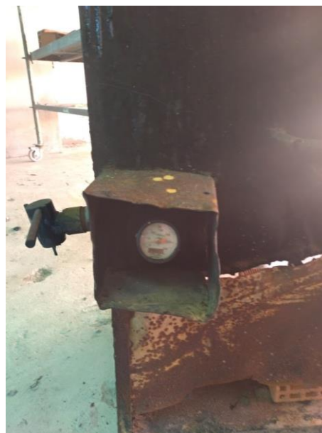
Figura 16 - Termômetro para controle do aquecimento do asfalto
