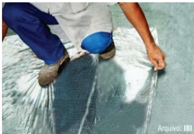
Figura 9 - Aplicação de camada separadora
