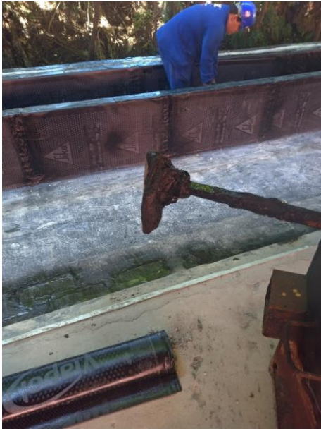
Figura 17 - Vassoura utilizada para aplicar e espalhar o asfalto
