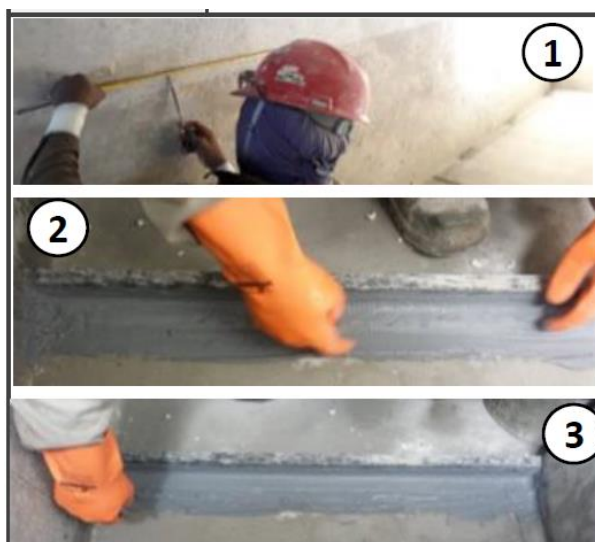
Figura 49 - Aplicação da tela estruturante no rodapé
