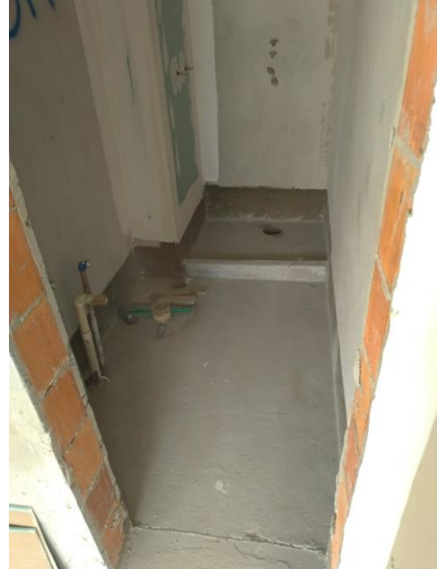
Figura 34 - Impermeabilização de banheiro pronta com proteção mecânica
