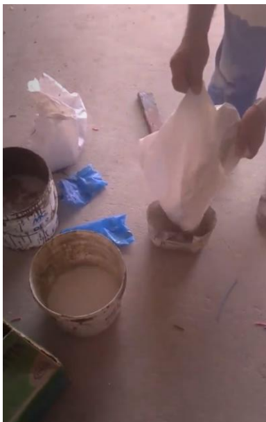
Figura 25 - Preparação da argamassa polimérica: medição da quantidade do componente em pó
