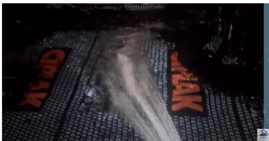
Figura 68 - Teste de estanqueidade
