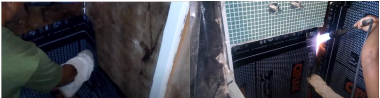
Figura 66 - Aplicação da manta sobre os rodapés e parede
