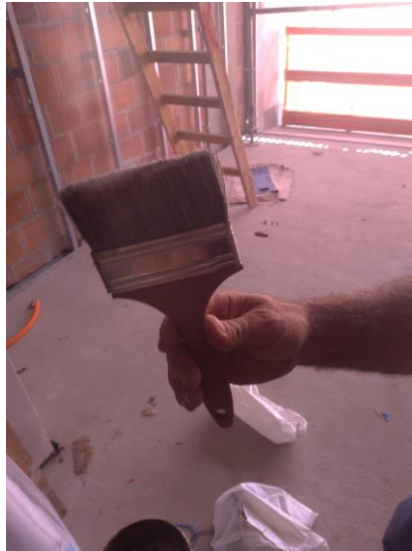
Figura 28 - Pincel utilizado para aplicar a argamassa polimérica
