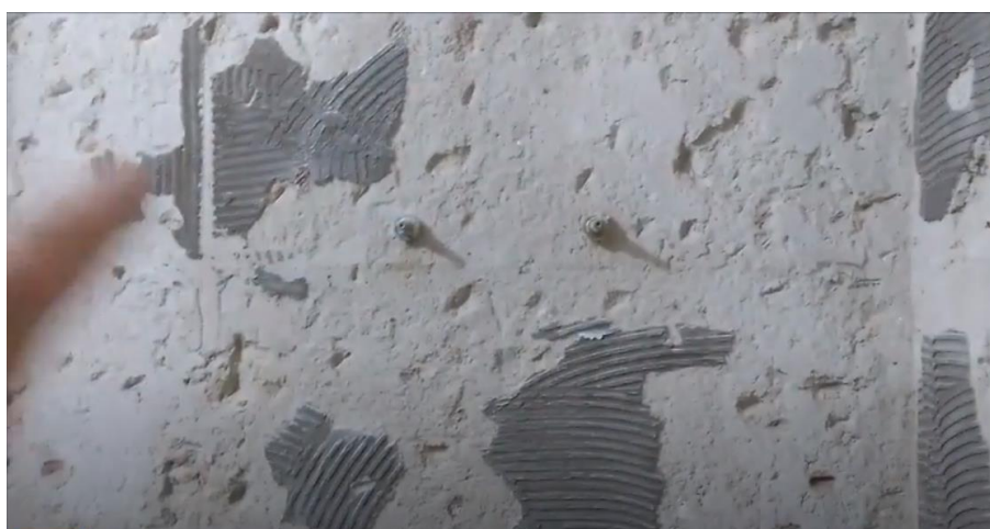
Figura 78 - Parede do Box que será impermeabilizada
