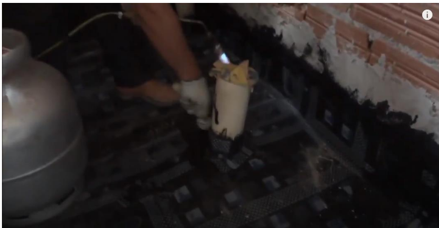
Figura 70 - Aplicação da manta em torno da tubulação
