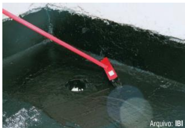
Figura 6 – Imprimação com emulsão asfáltica
