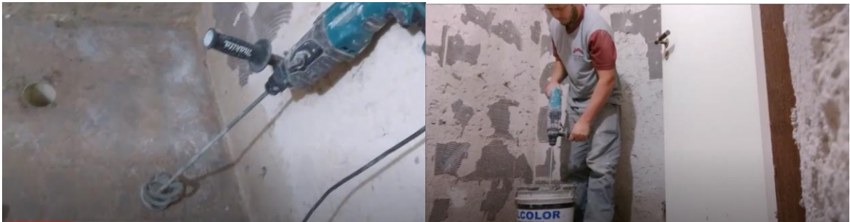
Figura 80 - Mistura dos componentes com agitador mecânico
