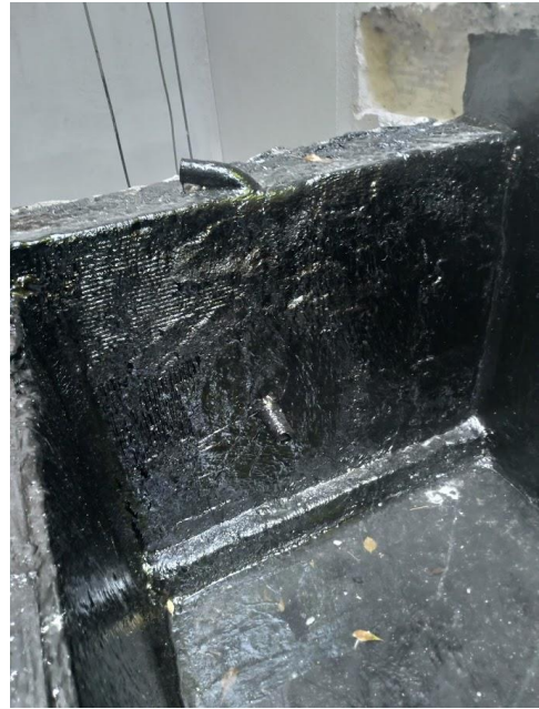
Figura 18 - Área com o asfalto aplicado
