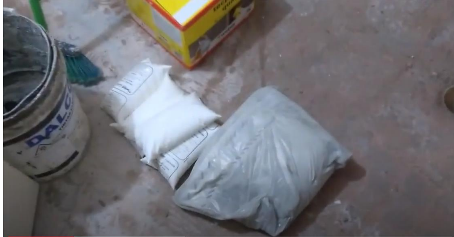
Figura 79 - Preparação da argamassa impermeabilizante
