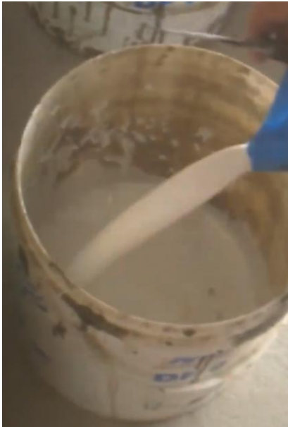
Figura 24 - Preparação da argamassa polimérica: adição do componente em resina líquida
