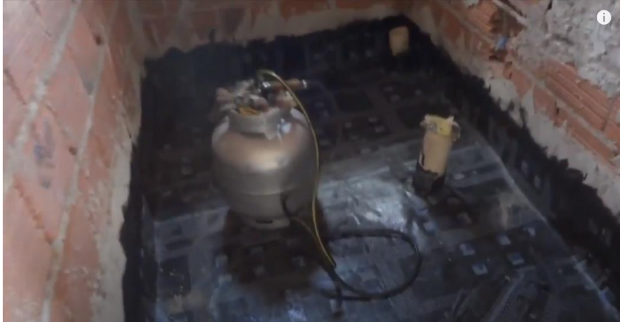
Figura 69 - Manta asfáltica aplicada em toda a superfície
