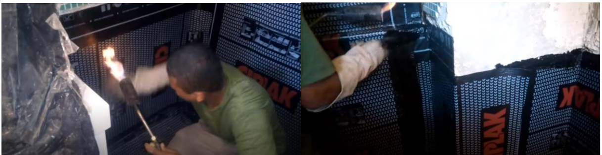
Figura 67 - Aplicação da manta na parede
