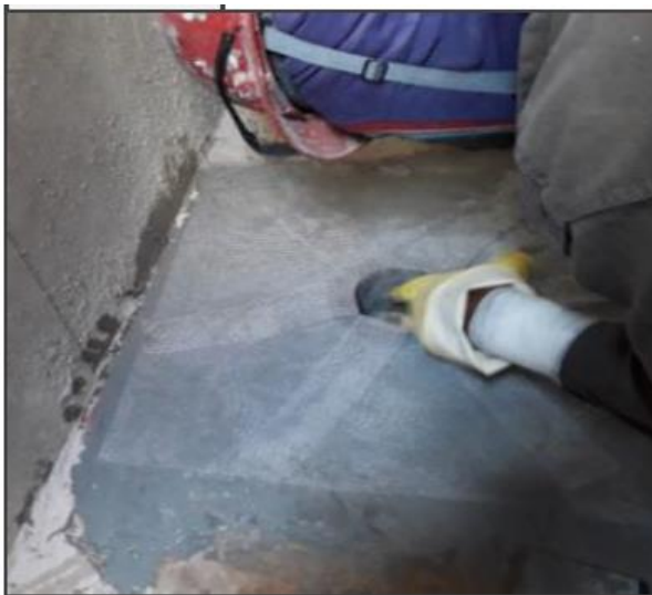
Figura 44 - Posicionamento da tela "margarida" na parte interna do tubo
