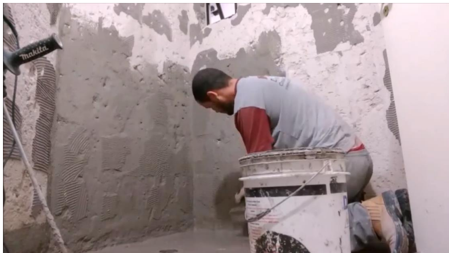
Figura 82 - Aplicação do impermeabilizante
