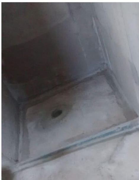
Figura 57 - Acabamento arredondado em formato meia cana executado em todas as arestas
