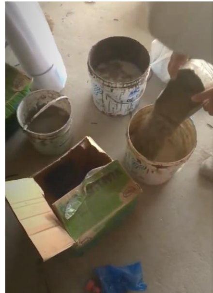
Figura 26 – Preparação da argamassa polimérica: adição do componente em pó
