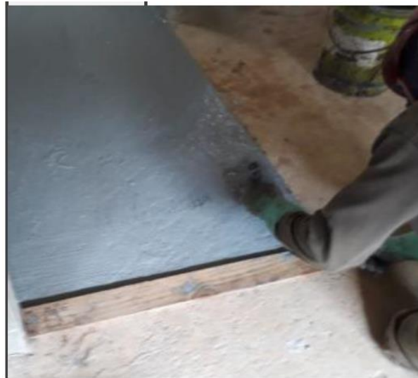
Figura 48 - Aplicação do impermeabilizante no piso da cozinha até a demarcação com a régua
