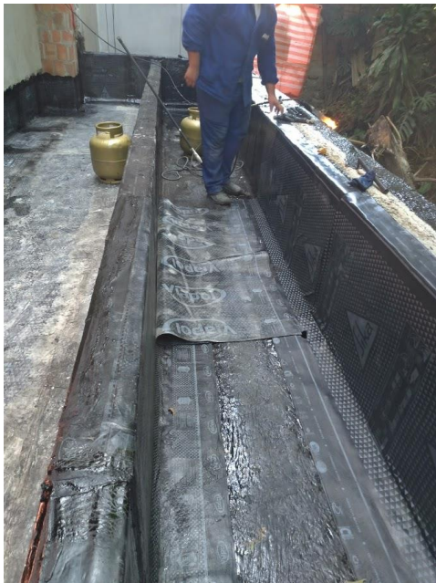
Figura 20 - Posicionamento da manta asfáltica
