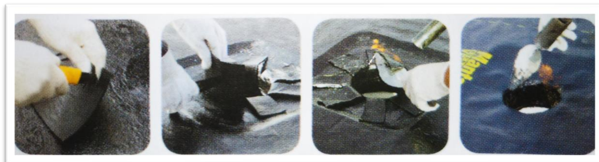
Figura 12 - Execução da impermeabilização com manta asfáltica em ralos
