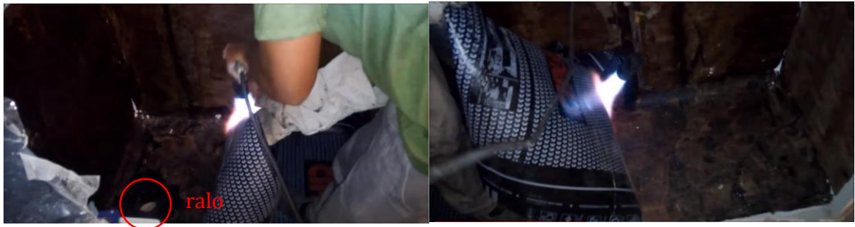
Figura 65 Aplicação da manta sobre o piso do box
