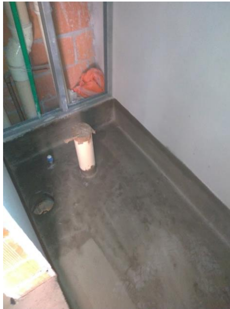
Figura 32 - Primeira demão de impermeabilização com argamassa polimérica no lavabo
