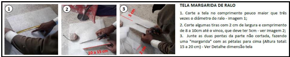
Figura 38 - Instrução para corte da tela estruturante posicionada no ralo
