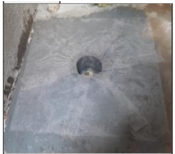
Figura 45 - Demonstração do posicionamento das telas estruturantes no ralo
