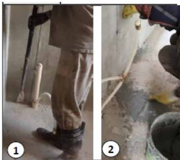
Figura 35 - Preparação da área a ser impermeabilizada
