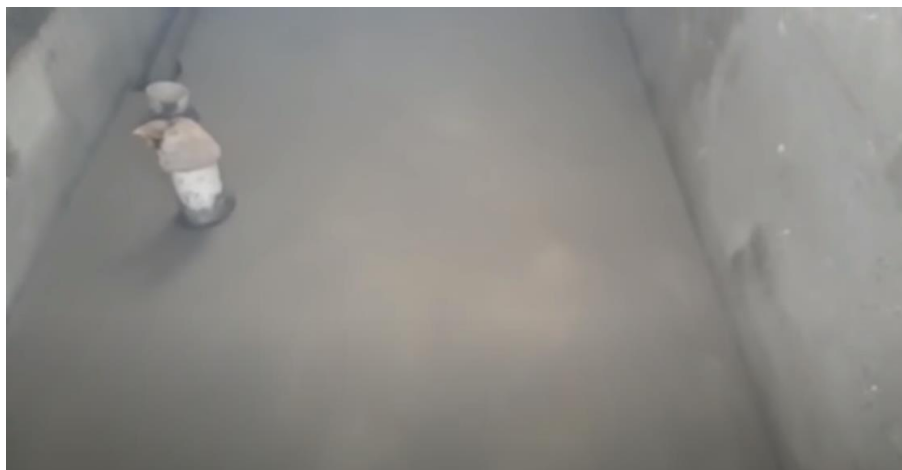
Figura 76 - Finalização da impermeabilização
