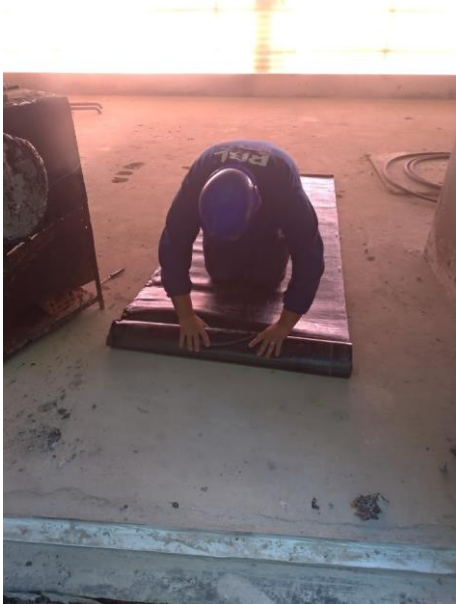
Figura 19 - Impermeabilização com manta asfáltica: preparação do material
