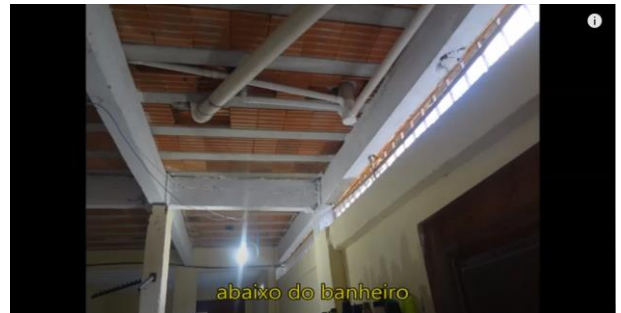
Figura 72 - Demonstração da laje durante o teste de estanqueidade
