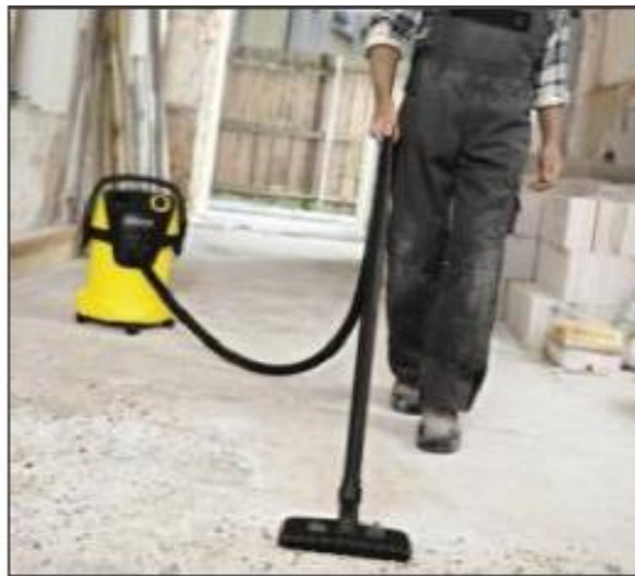
Figura 37 - Limpeza do local que será impermeabilizado
