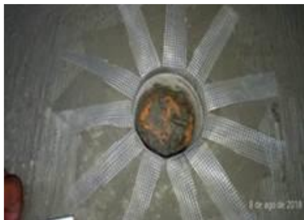
Figura 61 - Posicionamento da tela no ralo
