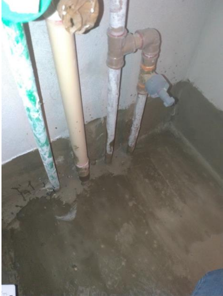
Figura 33 - Primeira demão de impermeabilização com argamassa polimérica no lavabo e detalhes de tubulações passantes
