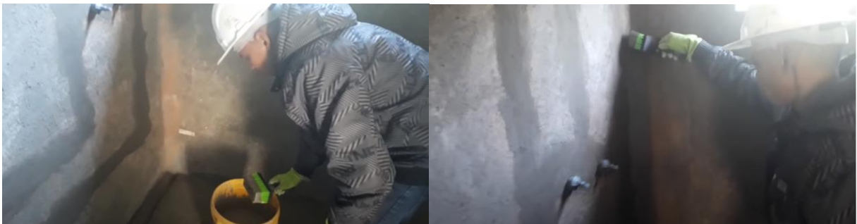
Figura 75 - Aplicação da argamassa na parede
