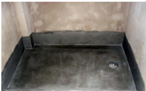
Figura 58 - Aplicação primeira demão do impermeabilizante
