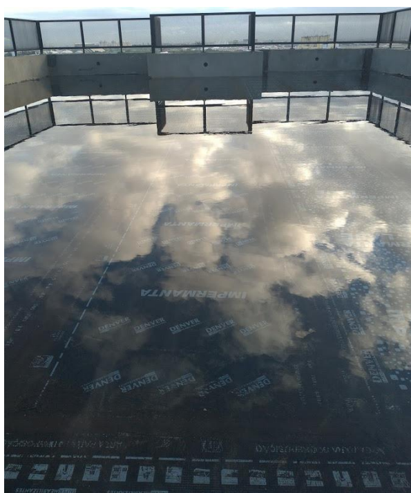
Figura 8 - Teste de estanqueidade da impermeabilização de laje de cobertura
