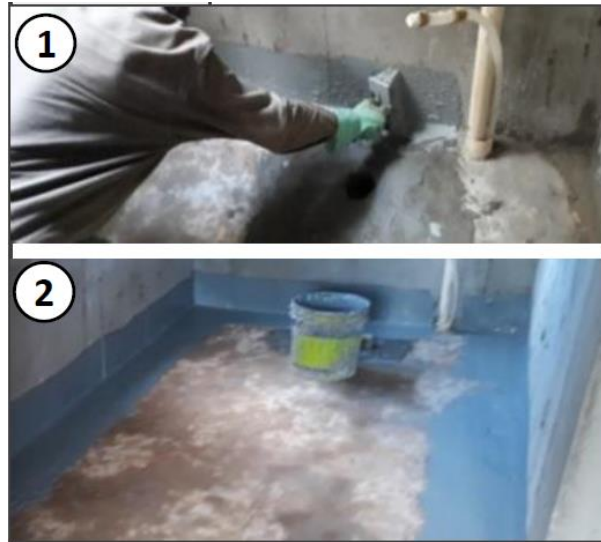
Figura 47 - Aplicação do impermeabilizante no rodapé e piso
