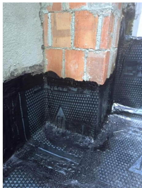
Figura 22 - Detalhe de rodapés e cantos arredondados
