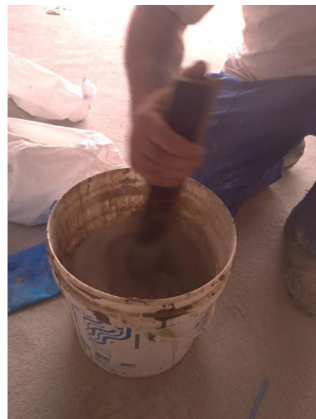
Figura 27 - Preparação da argamassa polimérica: agitação da mistura
