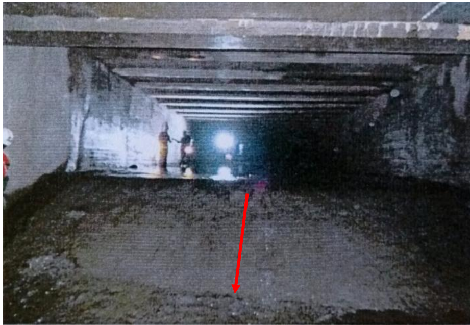
Figura 10 – Degrau inclinado 1V:2H da macrodrenagem
