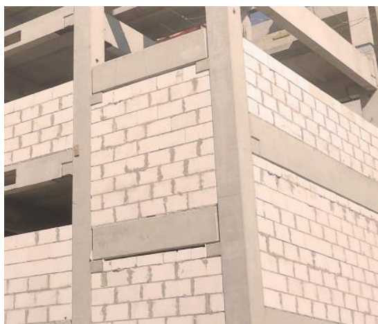
Figura 21 - Alvenaria com blocos de concreto celular
