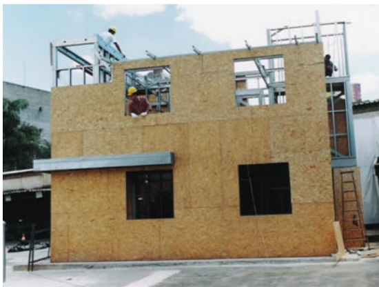
Figura 9 - Fachada com fechamento externo em OSB
