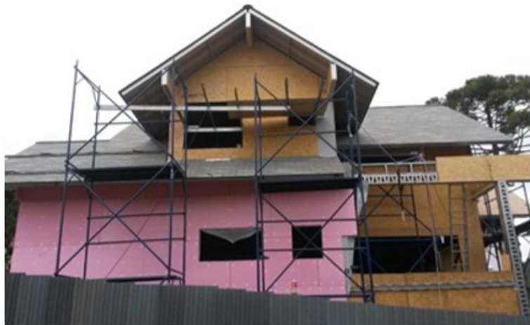
Figura 15 - Aplicação de chapas OSB e XPS
