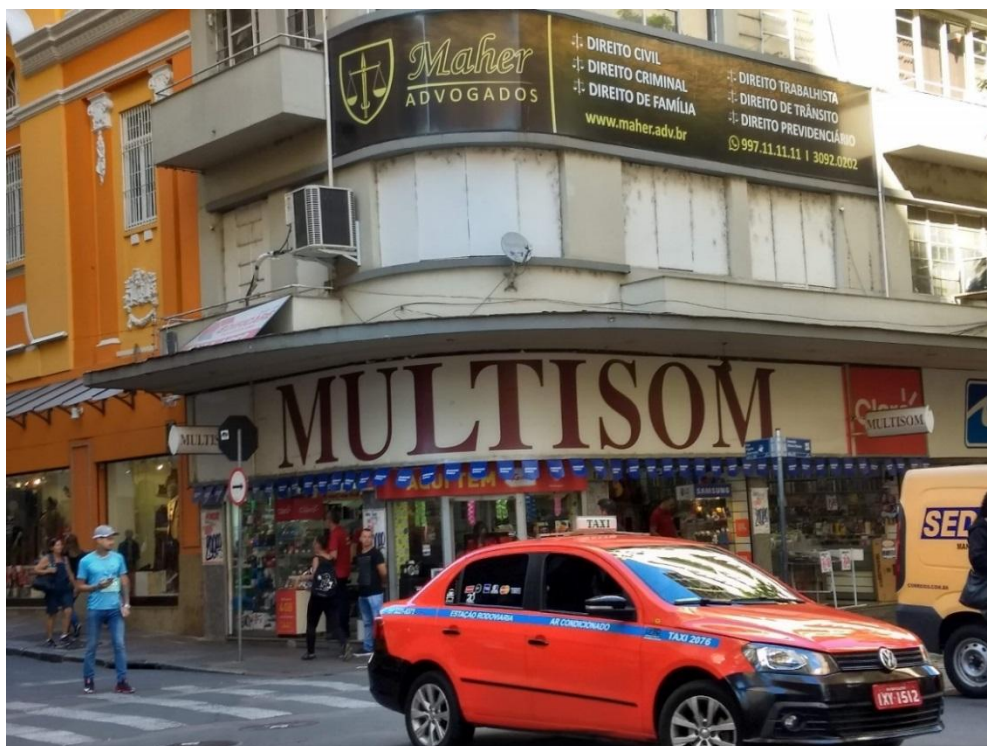
Figura 14 - Marquise com estrutura formada por laje em balanço, em curva, sem sinais de sobrecargas
