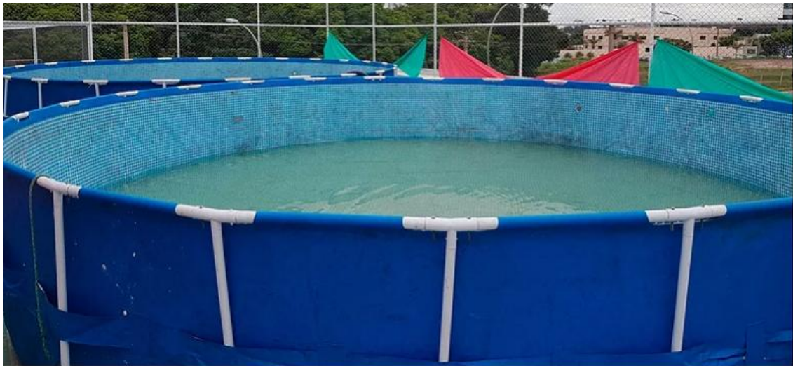
Figura 38 - Aplicação de carga em prova de carga através de piscina desmontáveis e água
