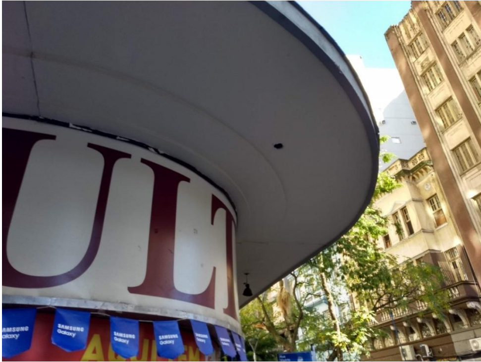
Figura 15 - Marquise com face inferior bem conservada, sem sinais de manchamento ou fissuração
