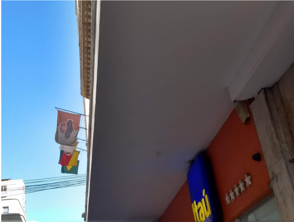
Figura 27 - Vista inferior, sem sinais fissuração ou manchamentos
