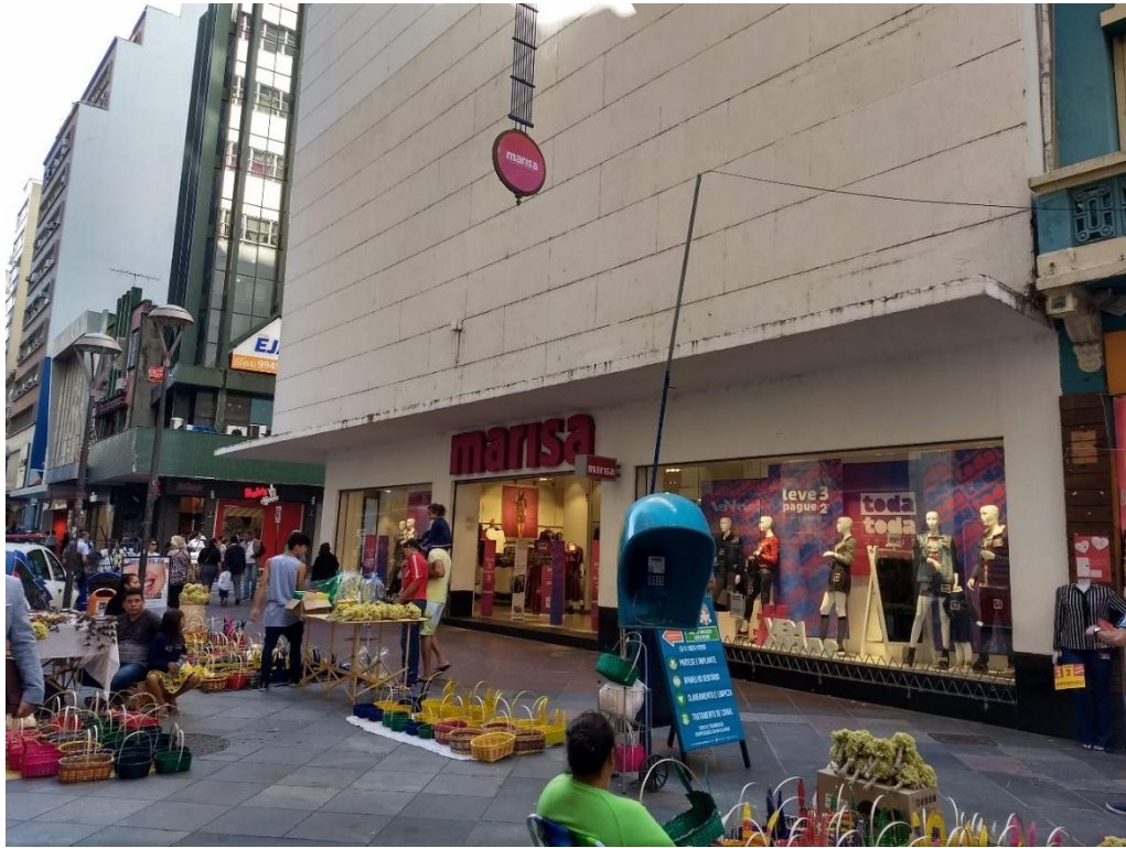
Figura 19 - Marquise com estrutura formada por laje em balanço, sem sinais de sobrecargas
