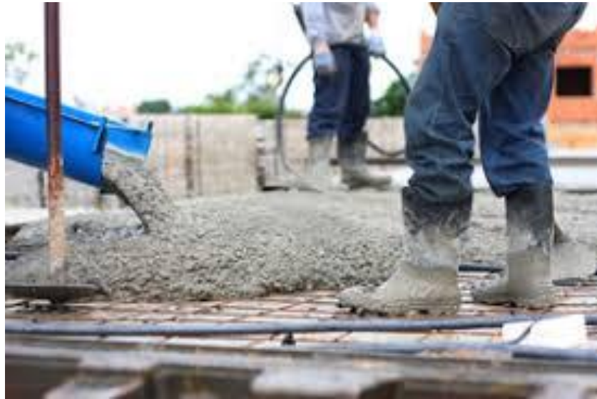
Figura 3 - Concretagem típica de laje, com os operários apoiados diretamente sobre as armaduras
