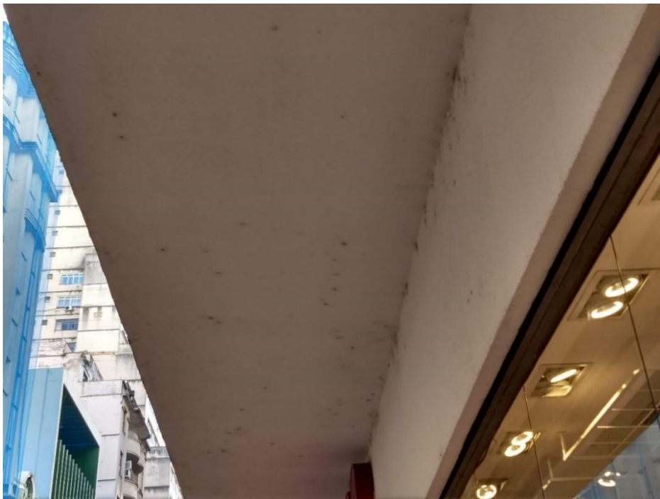
Figura 20 - Ausência de sinais de infiltração, fissuras ou manchamentos
