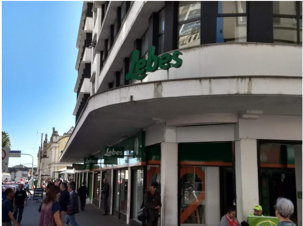
Figura 17 - Marquise com estrutura formada por laje em balanço, em curva, sem sinais de sobrecargas
