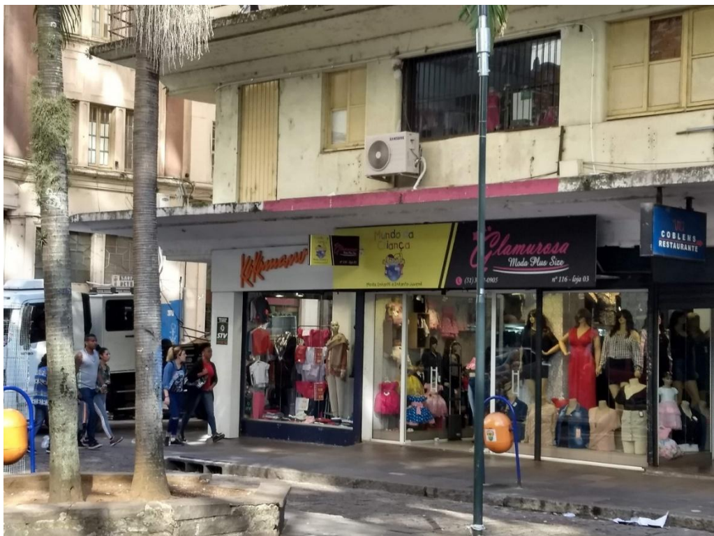
Figura 12 - Marquise com estrutura formada por laje em balanço, sem sobrecargas
