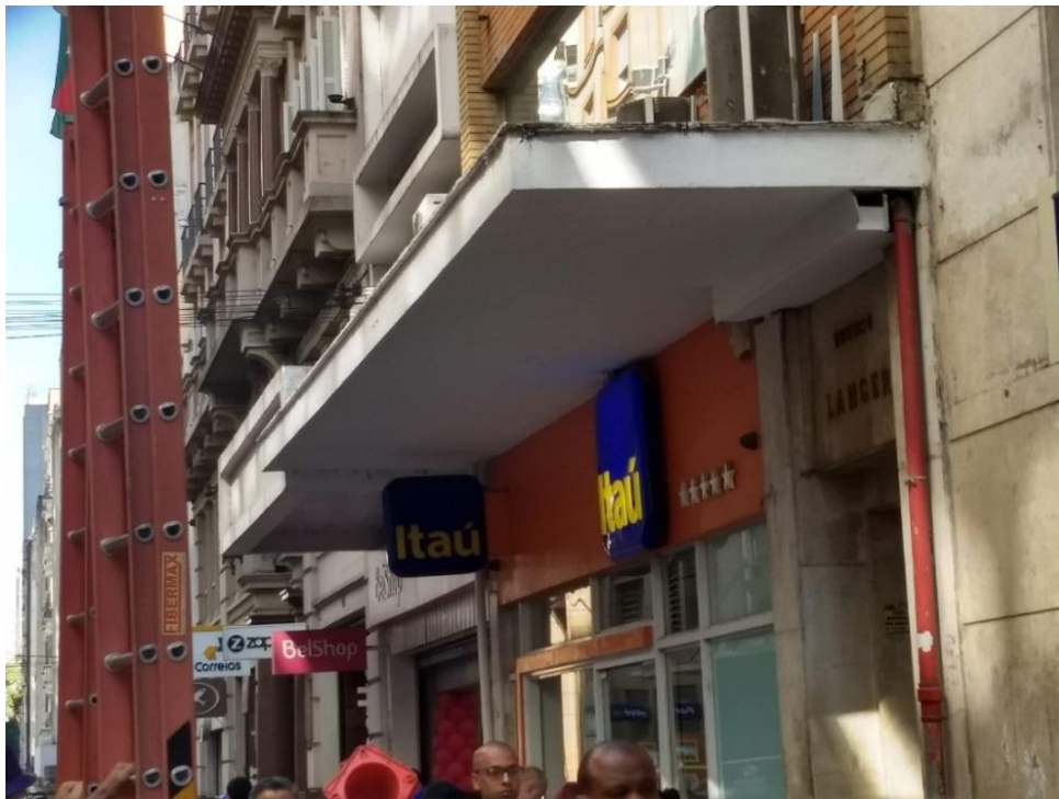
Figura 26 - Marquise com estrutura formada por laje em balanço, sem sinais de sobrecargas. Houve o cuidado de fazer a fixação do condensador do aparelho de ar-condicionado na parede de fachada, utilizando mão-francesa, não gerando desta forma sobrecarga para a marquise.
