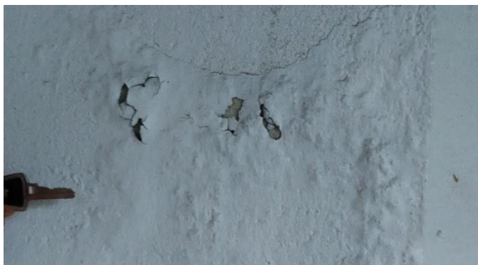
Figura 10 – Empolamento da tinta na EE Nova
