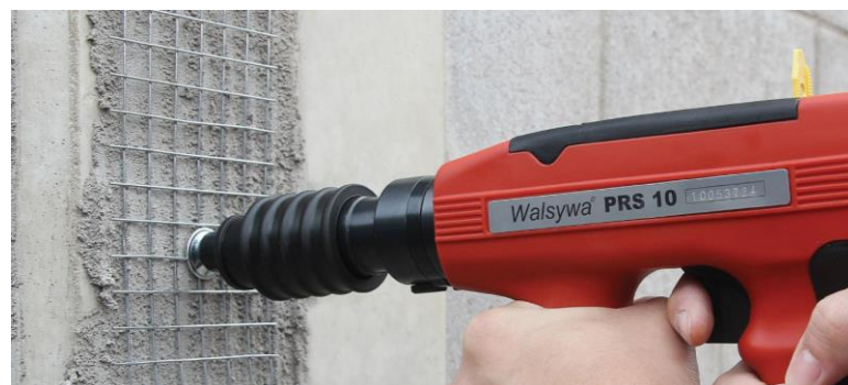
Figura 31 – Fixação da tela com pistola
