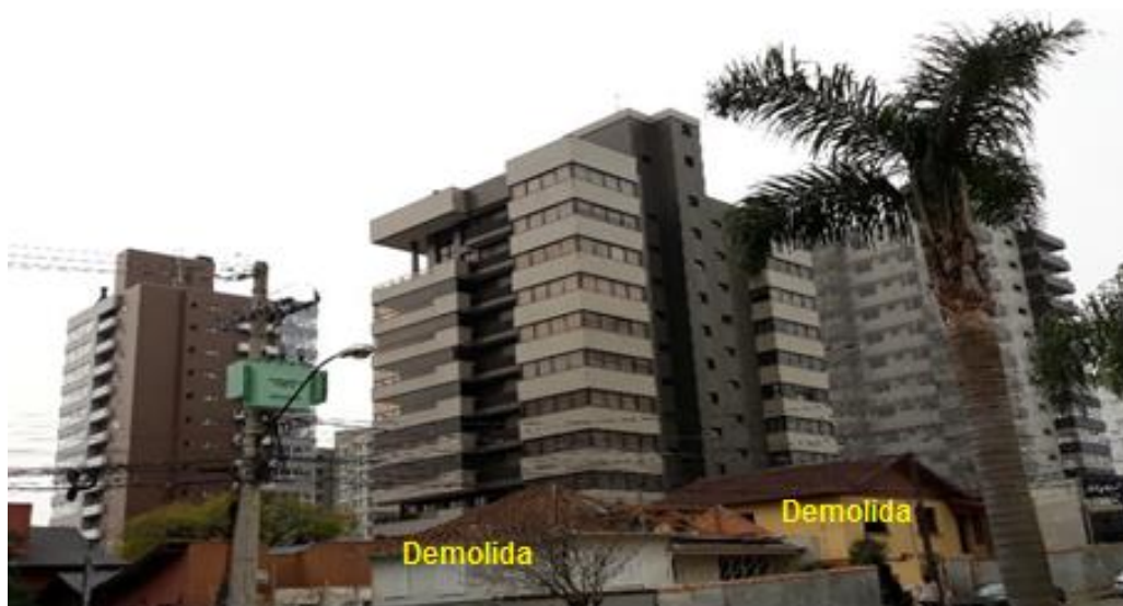
Imagem 130 – Ponto de visão 2 do pedestre nas ruas assinaladas no mapa anterior com a marcação de obras residenciais demolidas no ano de 2019. VER ANEXO Fonte: Fotos da autora (2019).
