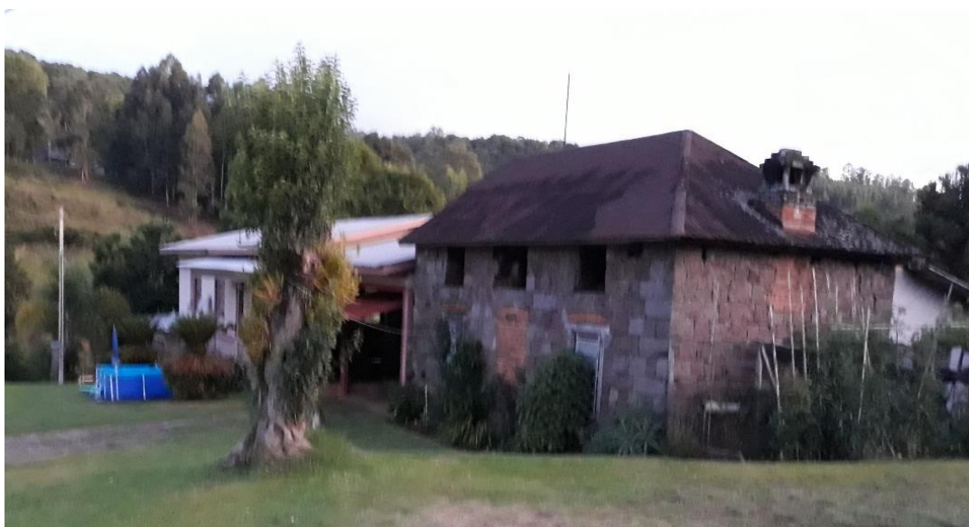
Imagem 180 – Casa de pedra do início do século XX – Eulália Alta – Vale dos Vinhedos com DO, Bento Gonçalves – RS Fonte: Fotografia da autora (2019).
