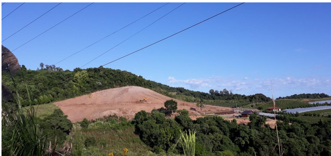
Imagem 156 – Movimentação de terra e alterações do relevo no Vale dos Vinhedos, para a construção de uma nova vinícola
