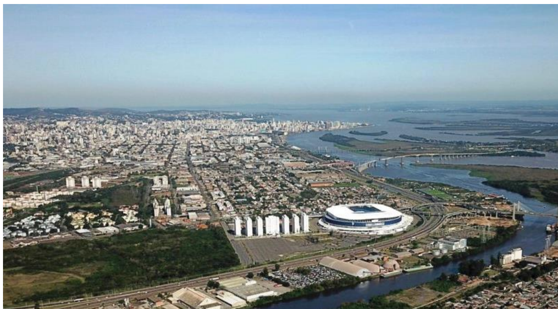
Figura 36 – Vista aérea atual do empreendimento e Porto Alegre, sentido N-S.
