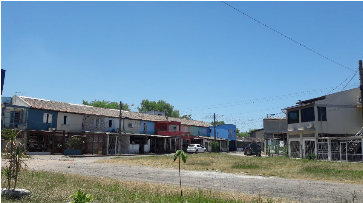
Figura 15 – PIEC na Av. Voluntários da Pátria, às margens da Free-way.
