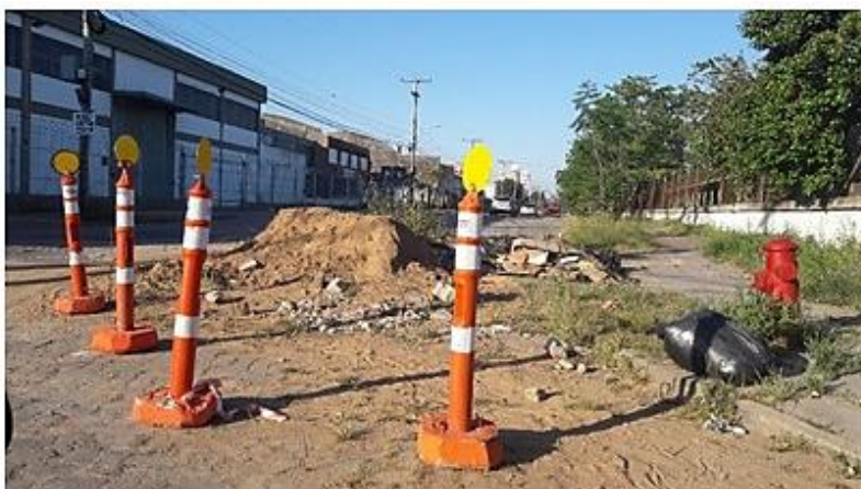
Figura 55 – Infraestrutura – Obras viárias na Av. Neugebauer, esquina R. Dona Teodora.
