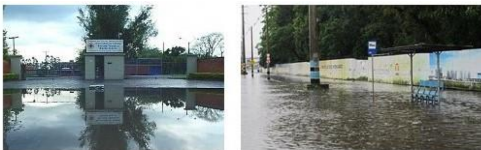
Figura 58 – Alagamentos no mesmo ponto da Av. Padre Leopoldo Brentano à época da Escola Santo Inácio e da Arena do Grêmio.
