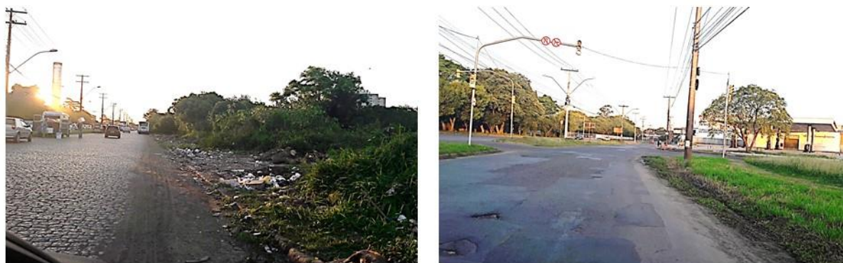
Figura 48 – Infraestrutura – Rua José Pedro Boéssio com permanentes problemas para tráfego de veículos e pedestres no trajeto entre Arena e Estação Trensurb Anchieta.
