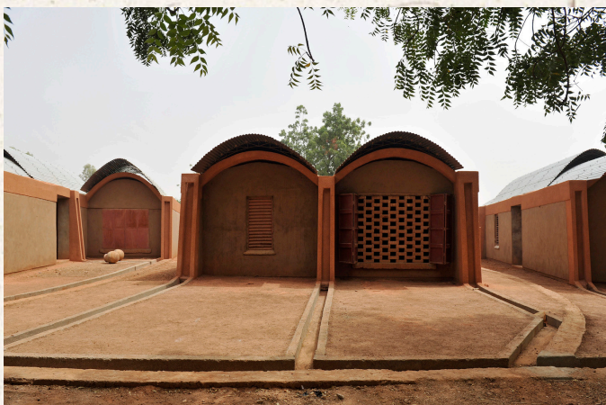
Moradia para os professores de Gando Kéré Architecture Burkina Faso Construção em terra - adobe
