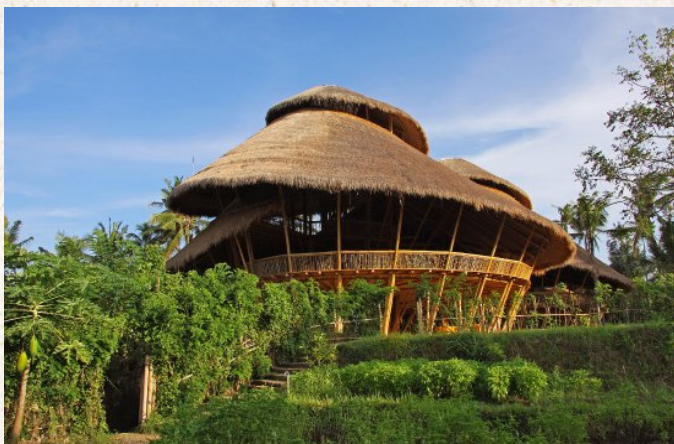
The Green School PT bamboo Bali, Indonésia Construção em bambu
