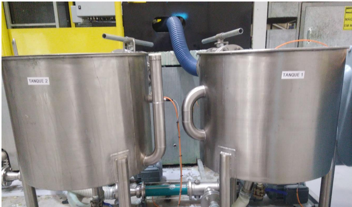
Figura 18: Tanques prontos e instalados para uso. Tanque 2 da direita usado para material branco e tanque 1 da esquerda para colorido (autor: Andersen Langendorf)
