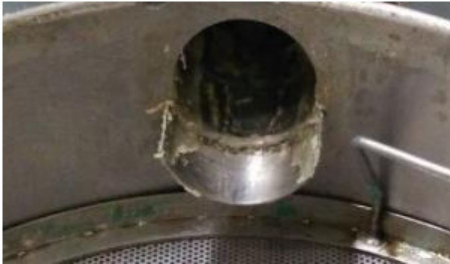
Figura 34: Prolongação do bocal de saída da resina da tubulação para o tanque
