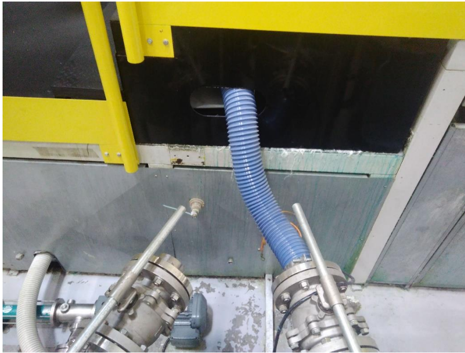
Figura 20: Troca da posição da mangueira de transporte de resina (autor: Andersen Langendorf)
