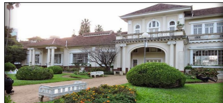
Prédio da Diretoria Geral
