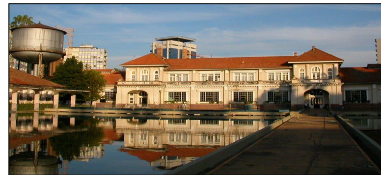
Decantadores, Reservatório e Prédio Diretoria Geral
