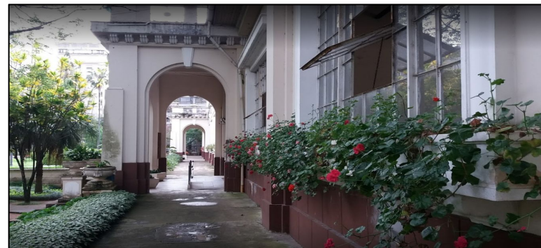
Arcos do Prédio da Diretoria Geral
